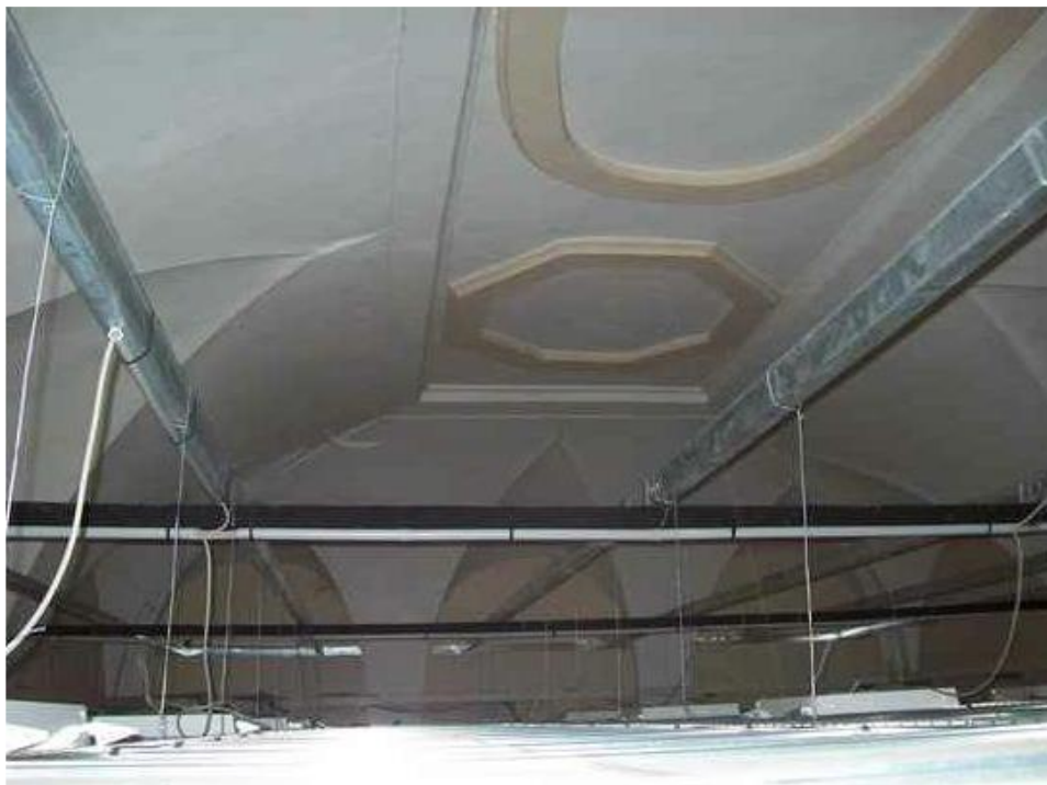
Foto 4: dettaglio soffitto piano terra
