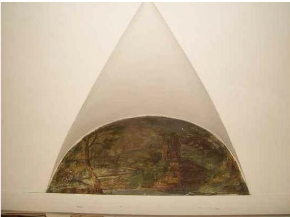
Foto 6: dettaglio piano secondo
