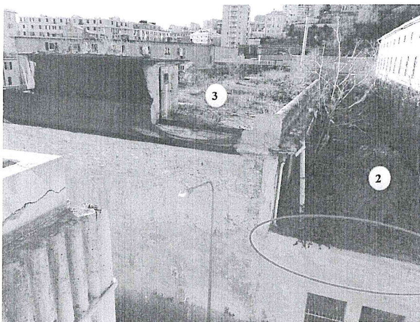
Fig. 6 – Porzione di muratura perimetrale a Sud-Est antecedente al crollo con evidenziazione della porzione di muratura perimetrale crollata
