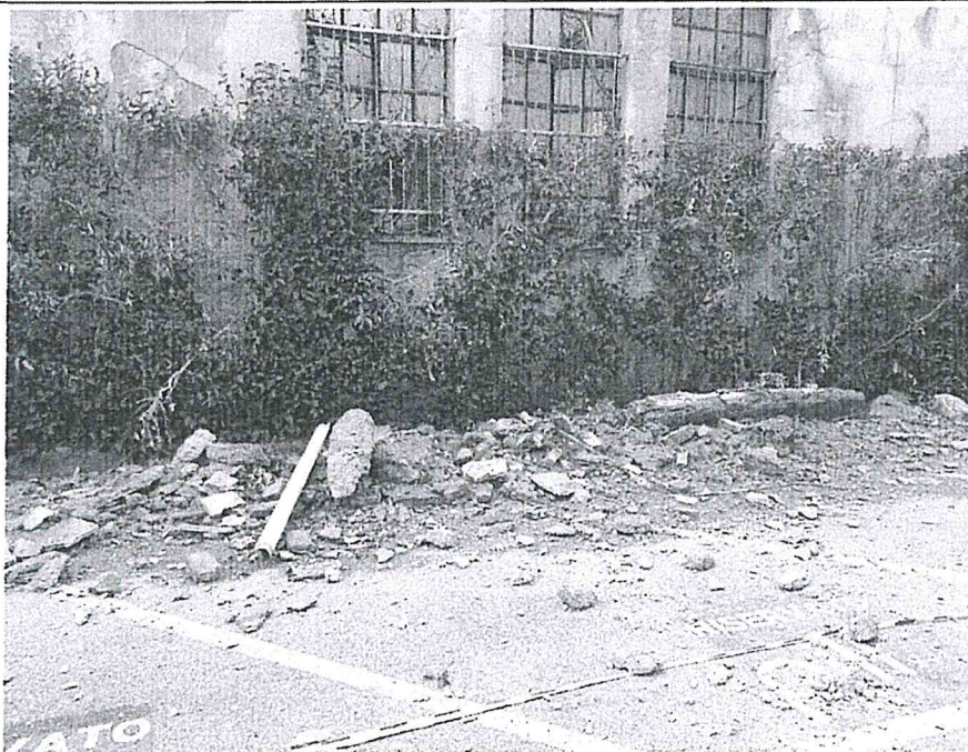
Fig. 9 – Crollo di porzione della muratura perimetrale sul fronte a Sud-Est
