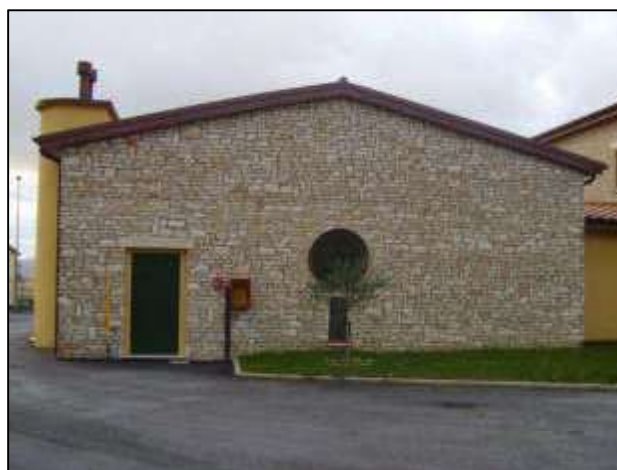
Facciata Nord del “corpo secondario”
