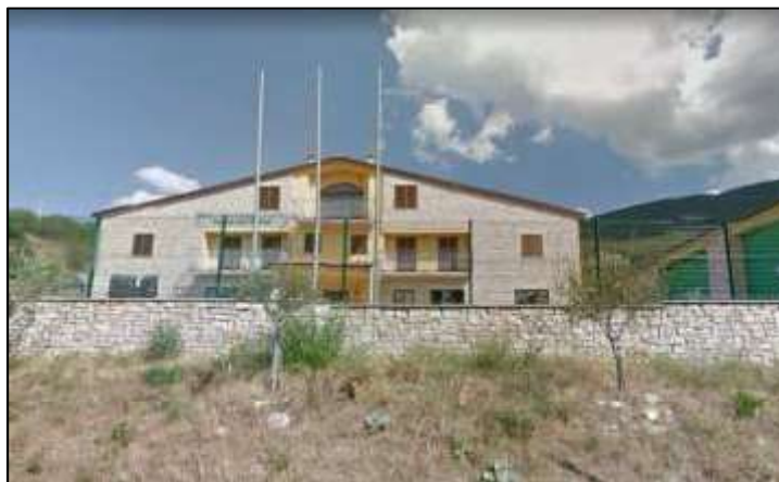
Facciata "corpo principale" prospiciente Via Valsorda
