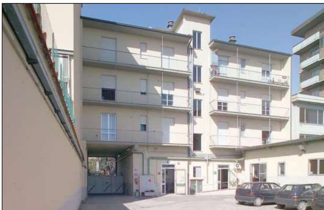
Retro fabbricato principale
