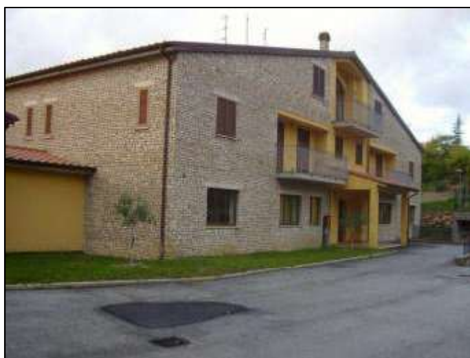
Facciata Nord del “corpo principale”
