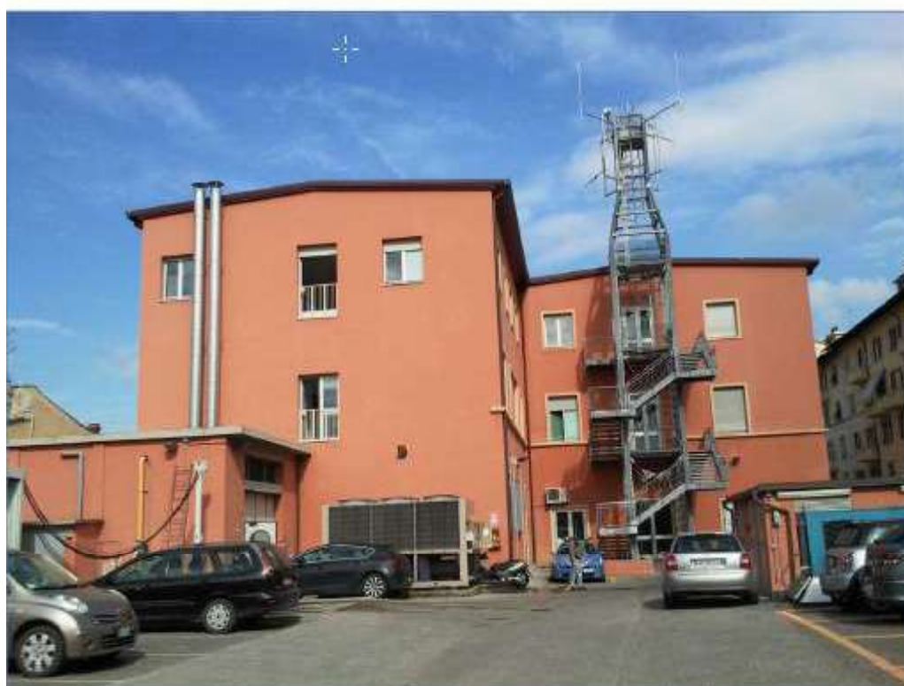
Foto n.2 – Caserma, centrale termica e cabina elettrica
