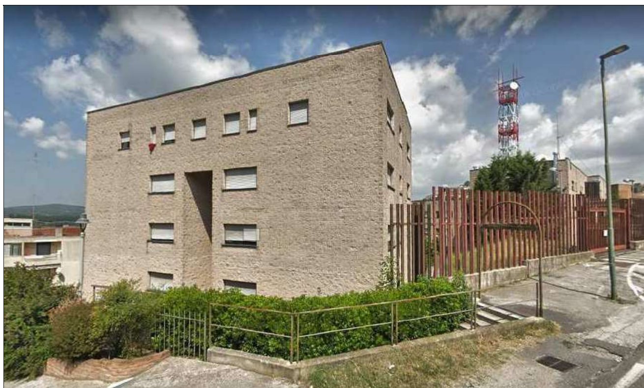
Palazzina alloggi (dalla strada)
