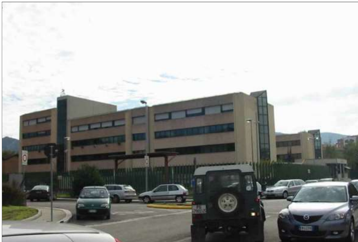
Uffici lato nord
