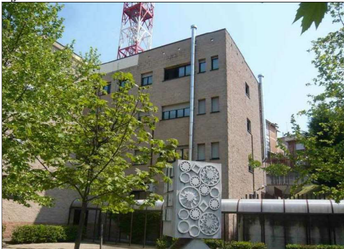
Caserma (dal cortile interno)
