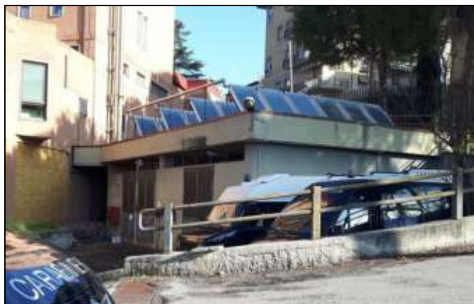
Foto 9: Fabbricato con impianti tecnologici
