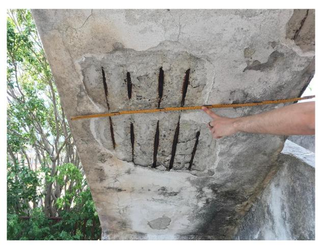
Il caso riportato è un chiaro esempio di depassivazione da carbonatazione: il copriferro, ormai totalmente soggetto al fenomeno di carbonatazione, si è completamente distaccato dalle barre di armatura, ormai a vista e ossidate.
