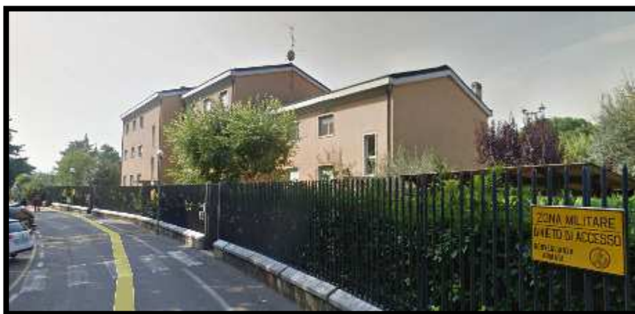
Fig. 4 – Vista Palazzina alloggi da Est
