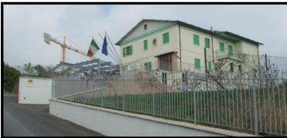
Fig. 2 – Vista da via Davide Menini (Sud-Ovest)
