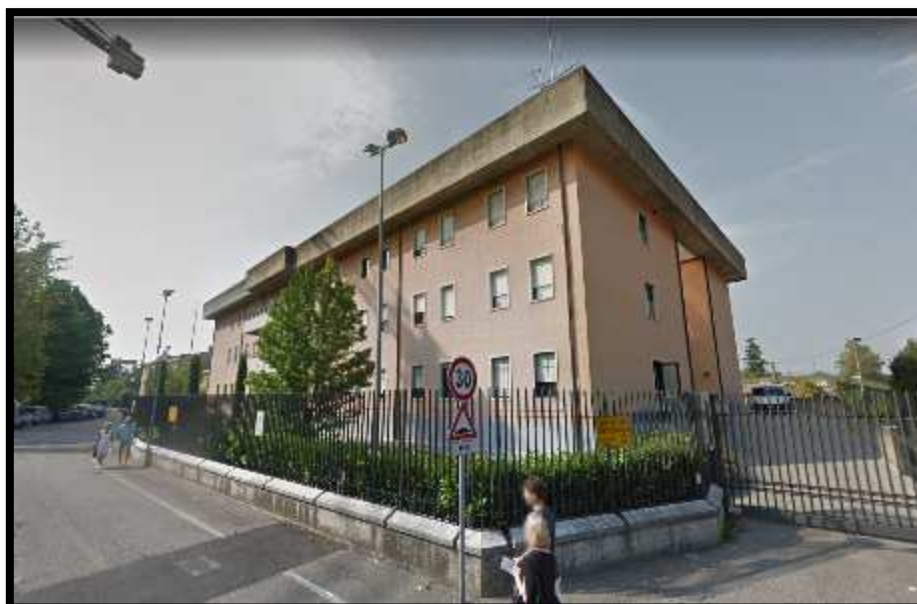
Fig. 1 – Vista Caserma da Nord-Est
