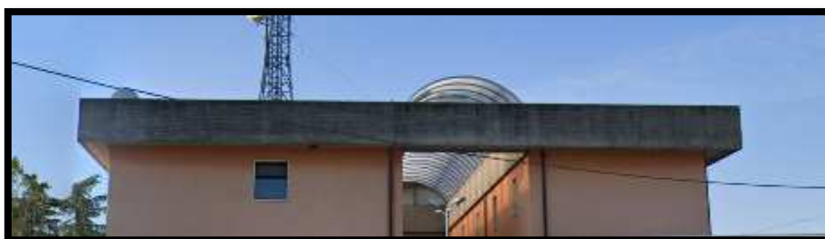
Fig. 3 – Vista Caserma da Nord: dettaglio copertura e galleria
