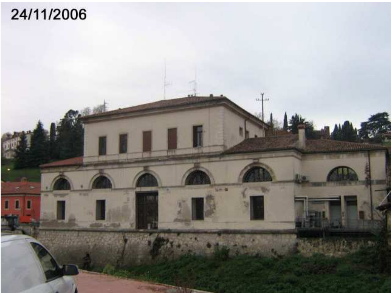
FABBRICATO VECCHIA DOGANA BORGO BERGA
