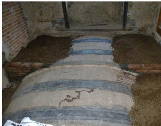
*Rinforzo di volta con Fibre in materiali compositi e frenelli e sostituzione del riempimento*
