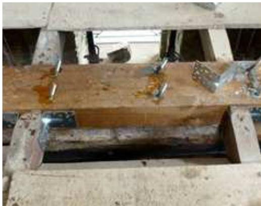
*Rinforzo di trave di legno mediante nuova sezione e connettori*
