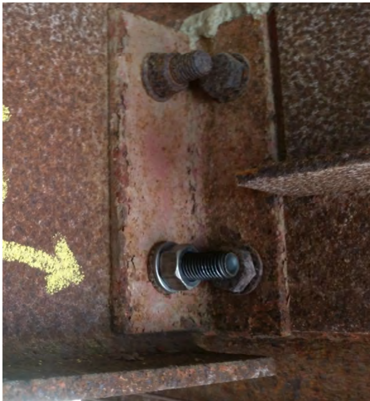
(Prelievo bullone e successiva sostituzione)
