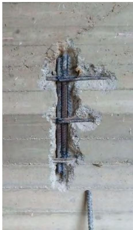
(Prelievo di una barra d'armatura e successivo ripristino strutturale)
