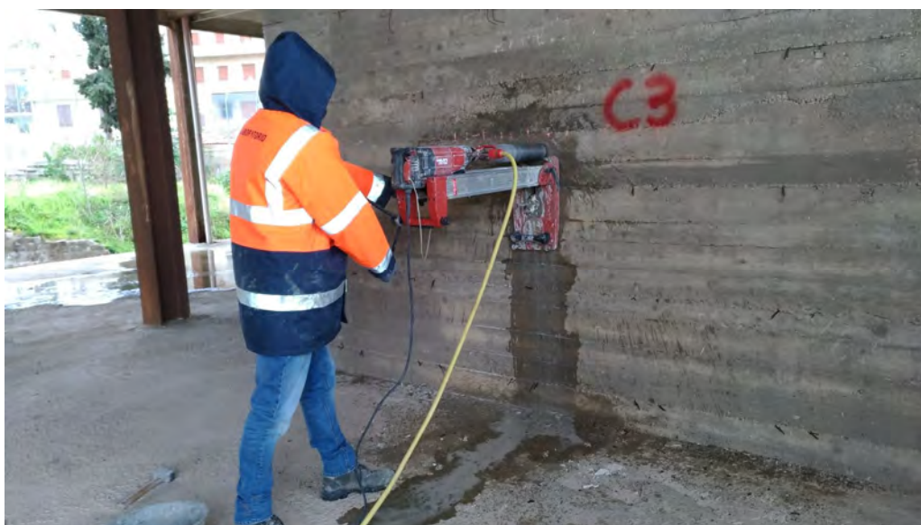
(Postazione di carotaggio ed attrezzatura utilizzata)
