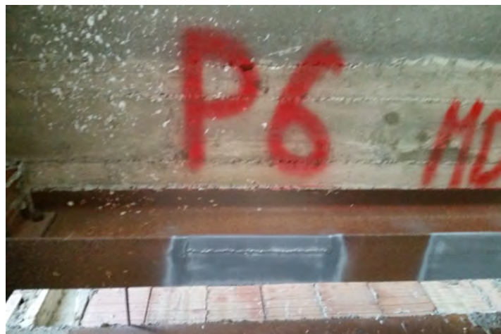
Ripristino del profilato metallico e zincatura
