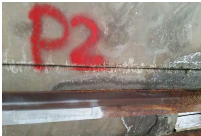
Ripristino del profilato metallico e zincatura
