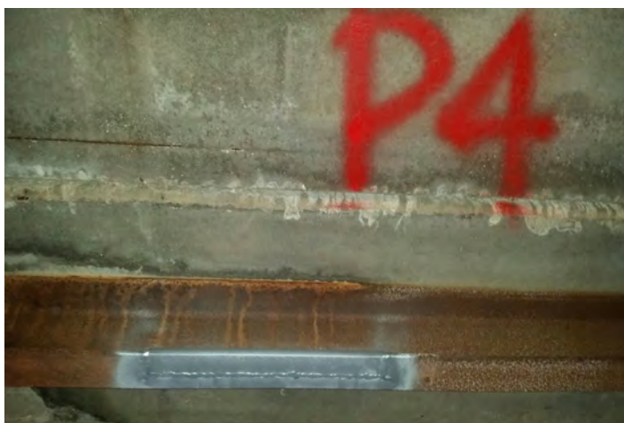
Ripristino del profilato metallico e zincatura
