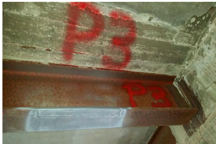
Ripristino del profilato metallico e zincatura
