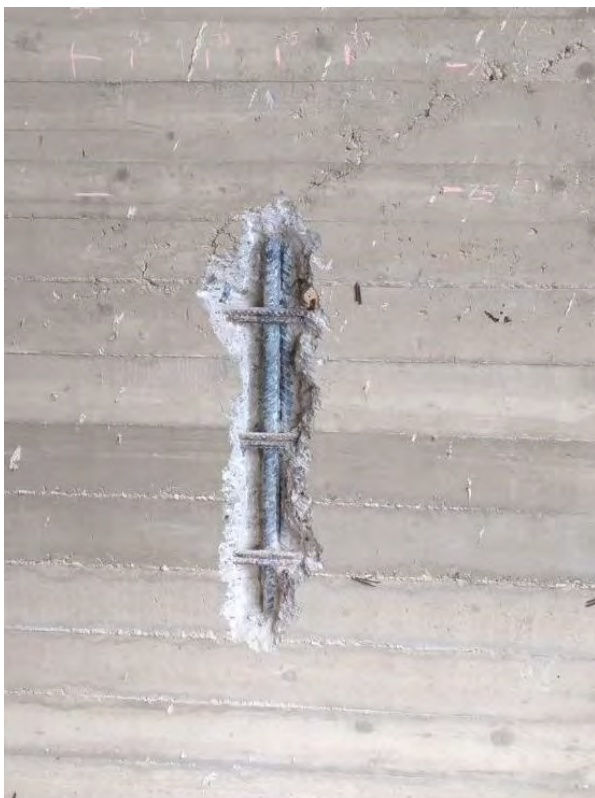
(Prelievo di una barra d'armatura e successivo ripristino strutturale)
