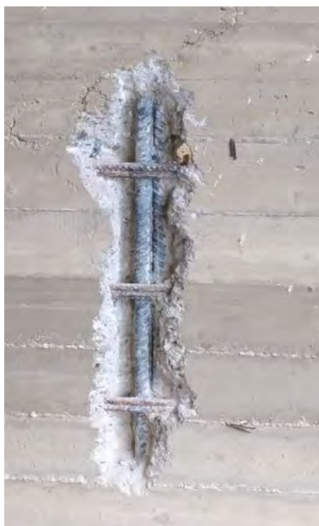
Ubicazione prelievo - Barra prelevata
