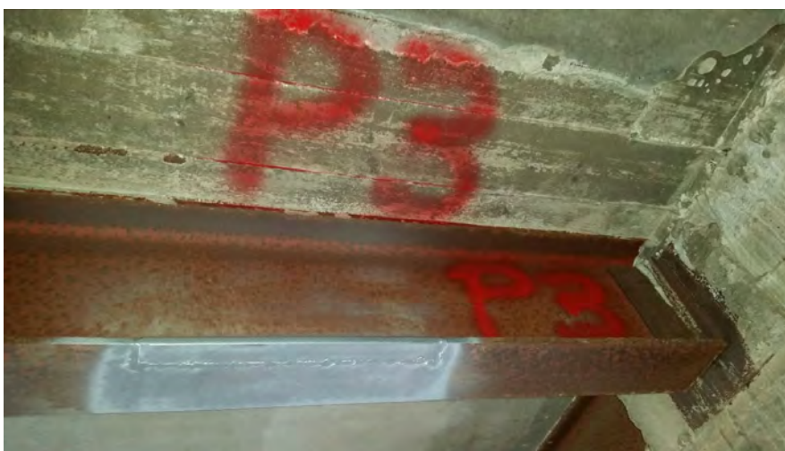
(Prelievo provino e successivo ripristino strutturale)
