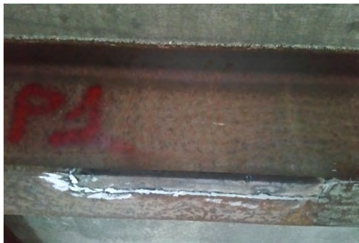
Ripristino del profilato metallico
