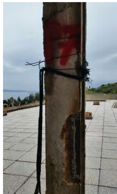
Ripristino del profilato metallico
