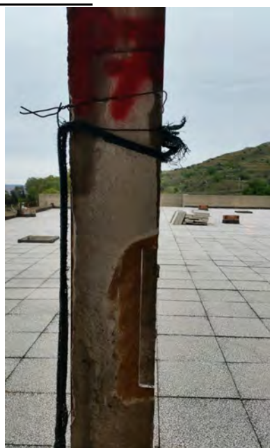
Prelievo del provino metallico
