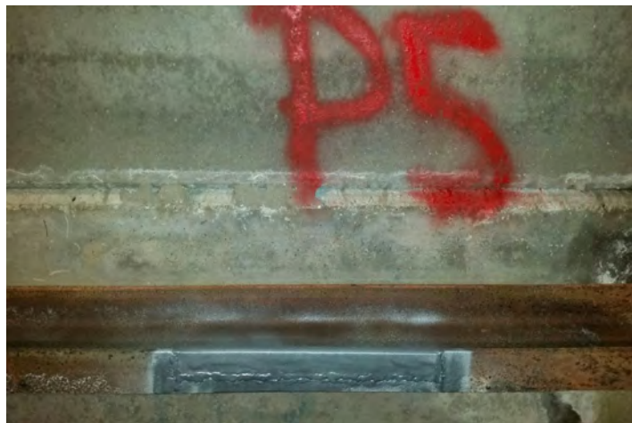
Ripristino del profilato metallico e zincatura
