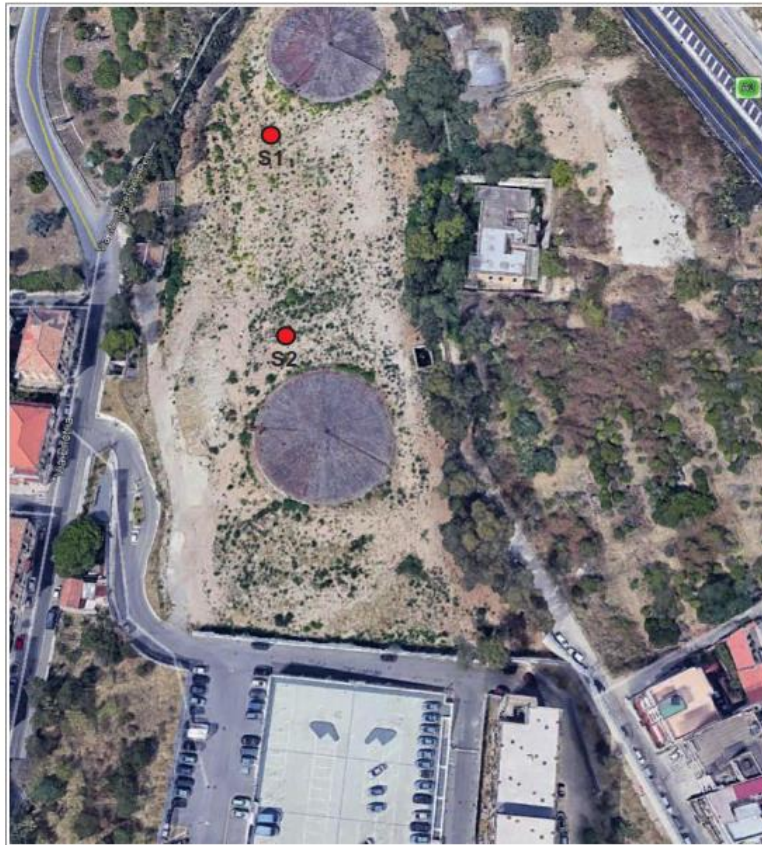
Ubicazione dei sondaggi stratigrafici (S1, S2)
