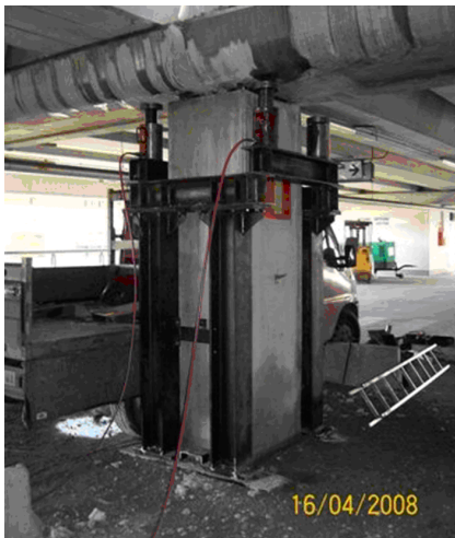
Figura 4 - Struttura provvisoria di contrasto
