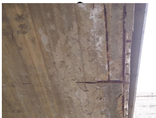
Dettaglio Scala in c.a./ distacco del copriferro
