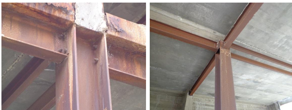
Dettaglio Nodi esterno e Nodi interno/attacco parete in c.a.
