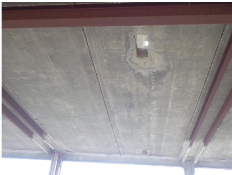
Solaio – Predalles di spessore 20cm
