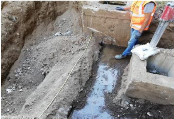
Particolari fondazione a zattera
