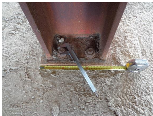
Dettaglio Nodo attacco colonna
