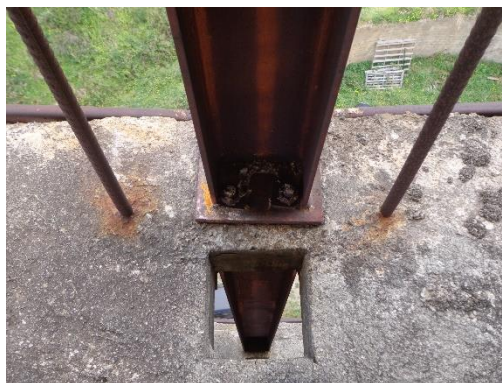
Particolare attacco pilastro
