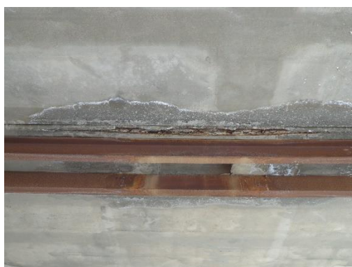
Dettaglio Predalles/distacco del copriferro
