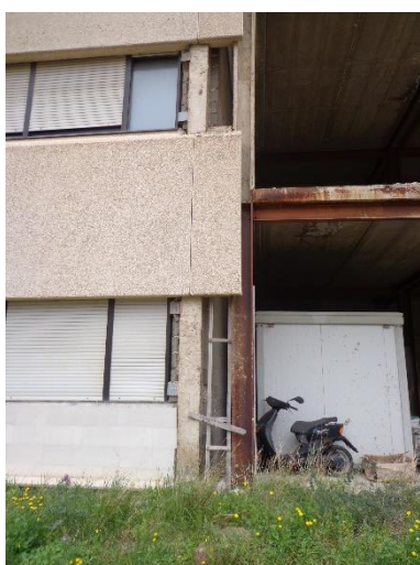
Dettaglio Nodo attacco colonna
