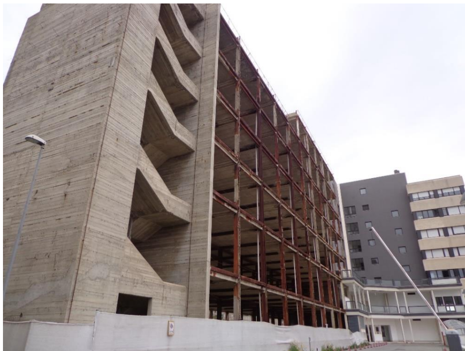
Prospetto Nord Est – Porzione scala con trave a ginocchio
