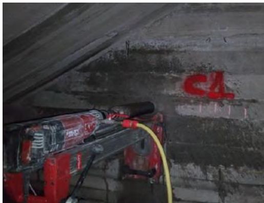
Esempio di prelievo di carote di calcestruzzo in elevazione ed in fondazione
