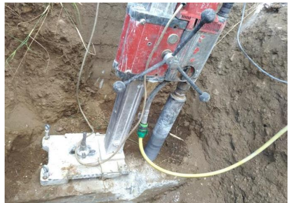
Esempio di prelievo di carote di calcestruzzo in elevazione ed in fondazione
