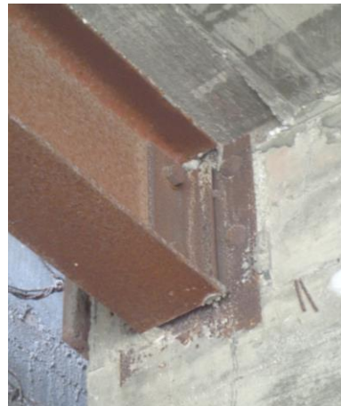
Esempi di controllo dei dettagli costruttivi e misure attacco travi in acciaio/pareti in c.a.
