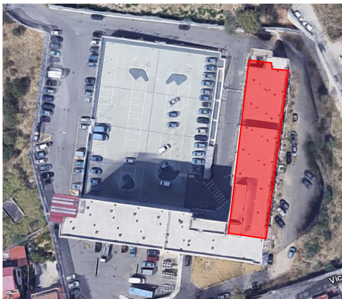
In rosso la porzione del fabbricato sottoposta a verifica
