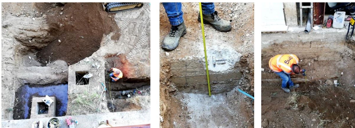
Esempi scavo e controllo delle dimensioni degli elementi in fondazione
