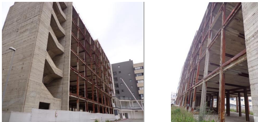
Vista del nucleo in calcestruzzo e del telaio in acciaio
