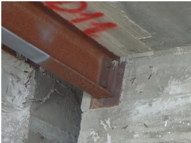
Esempi di controllo dei dettagli costruttivi e misure attacco travi in acciaio/pareti in c.a.
