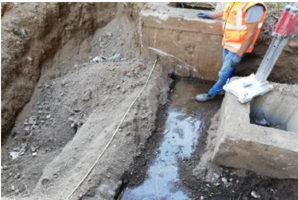
Particolari fondazione a zattera
