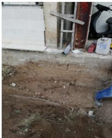
Particolari fondazione a trave rovescia
