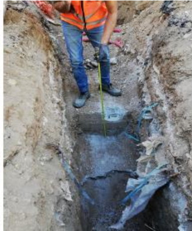
Particolari fondazione a zattera
