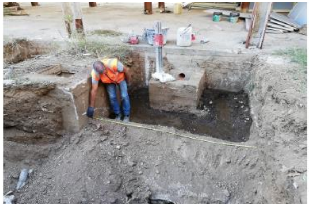
Particolari fondazione a zattera
