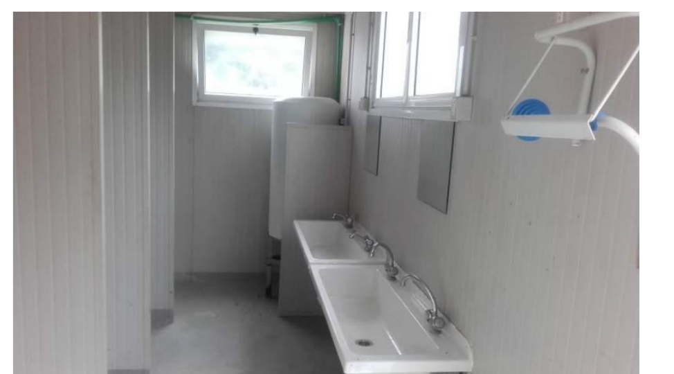
Esempio di bagno di cantiere
