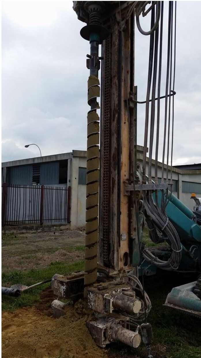
Perforazione a distruzione continua
