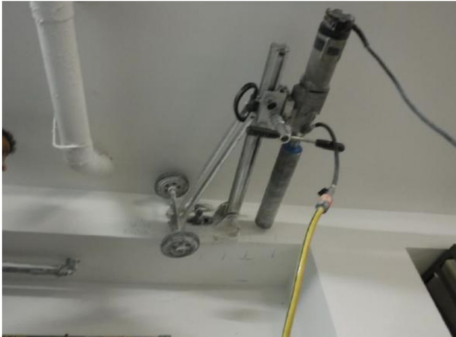
Foto: trave Pil31-Pil32 in carpenteria di Piano Rialzato, dimensione 30x50 cm
