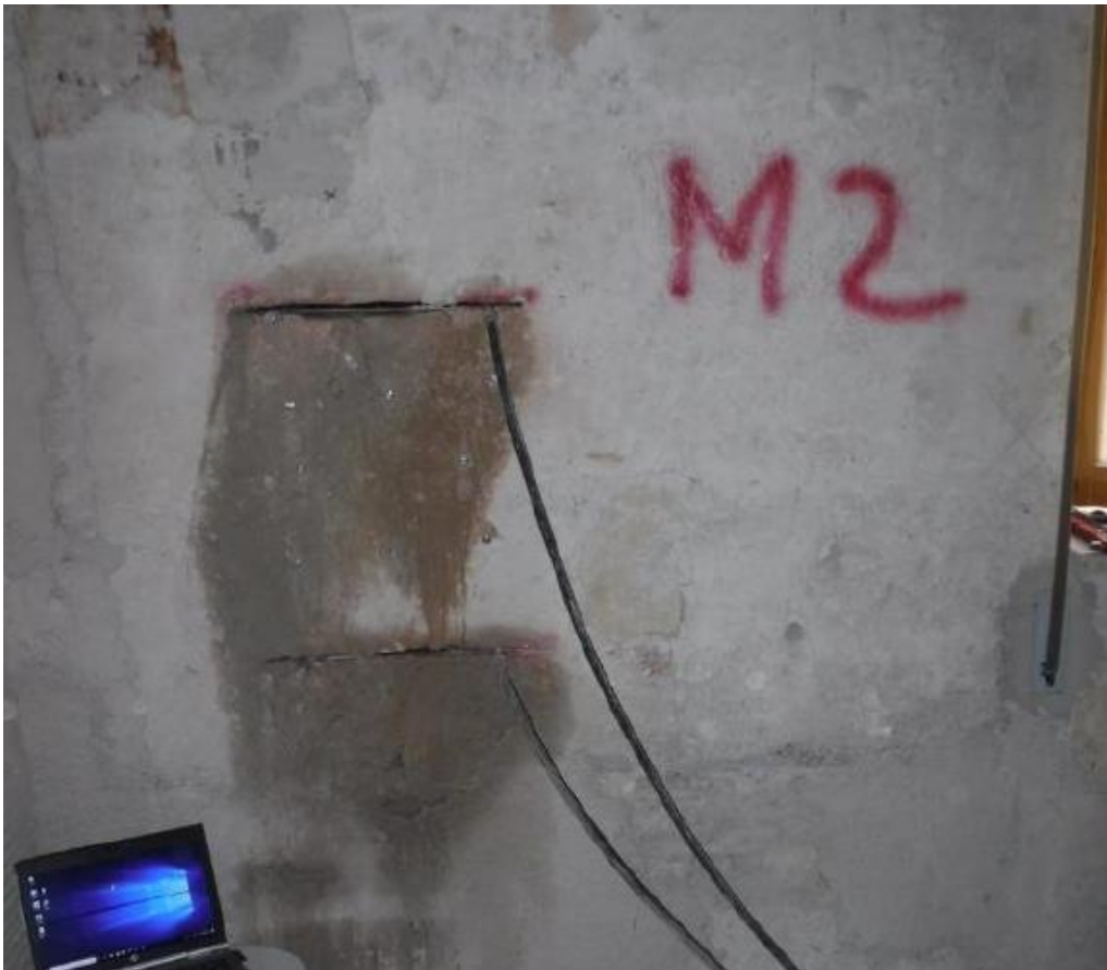
Foto: Muratura in tufo dello spessore di 60 cm, prova Martinetto Piatto Doppio, Secondo Piano
