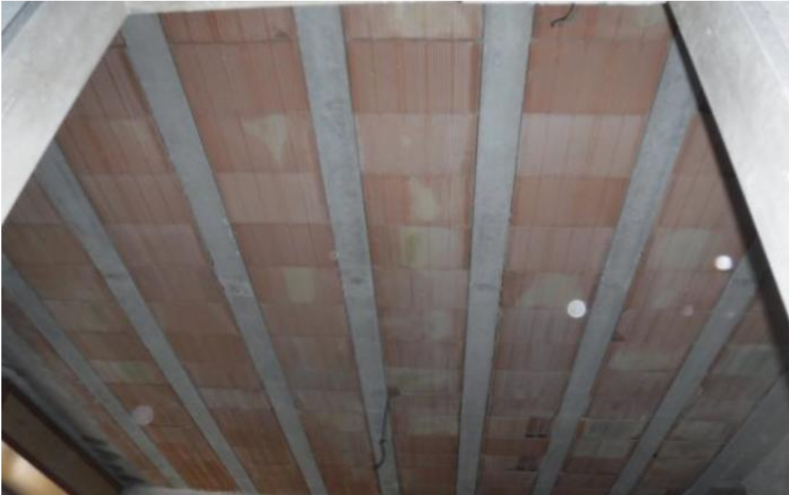
Foto: Solai a rustico a Piano Primo solo ad estradosso, Piano Secondo e Terzo sia ad intradosso che ad estradosso ed ad intradosso Solaio di Lastrico Solare
