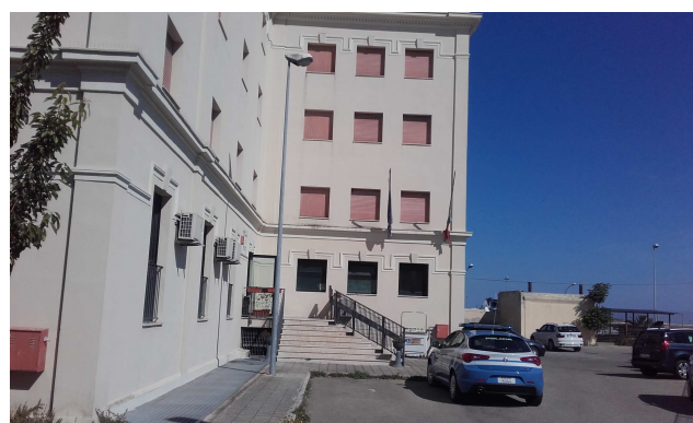
Particolare della scala di accesso al piano rialzato
