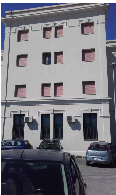
Prospetto nord-est, particolare
