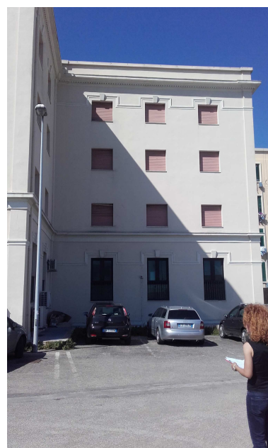
Prospetto nord-est, particolare
