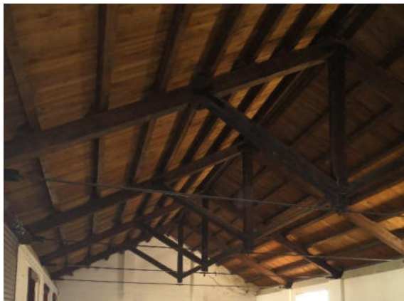
Figura 7 - Capriate in legno, Palazzina 6
