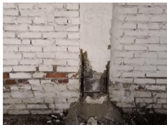
Figura 18 – Plinto e pilastro, Palazzina G
