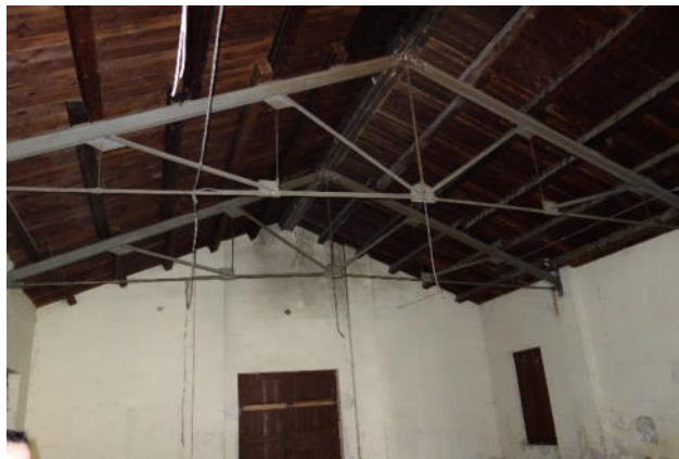
Figura 8 - Capriate in acciaio, Palazzina N
