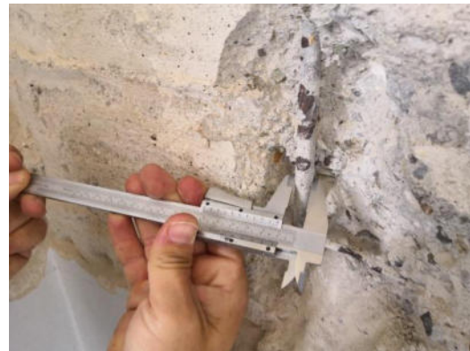
Figura 16 – Saggio e misurazione armatura
