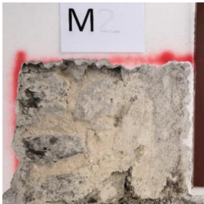
Figura 9 - Muratura in pietra a spacco con buona tessitura
