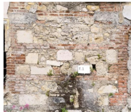
Figura 12 - Muratura in pietra a spacco con buona tessitura con ricorsi o listature
