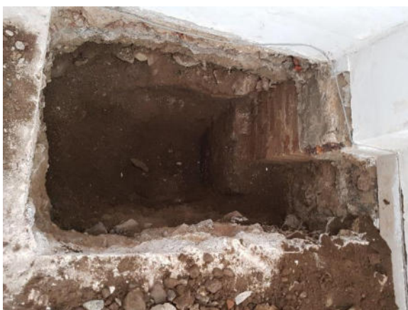
Figura 17 – Trave di fondazione, Palazzina 1
