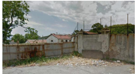
Resti del Portale di ingresso su via Comunale Bisconte
