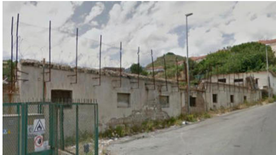
Resti della demolita Palazzina M su via Comunale Bisconte
