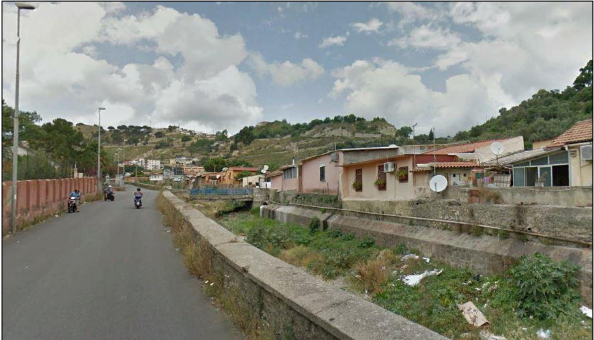
Foto n° 2 – La Fiumara Catarratti latitante immediatamente a valle l'area della Caserma Masotto la cui recinzione rossa è visibile nella foto
