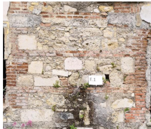
Figura 6 - Muratura in pietra a spacco con buona tessitura con ricorsi o listature
