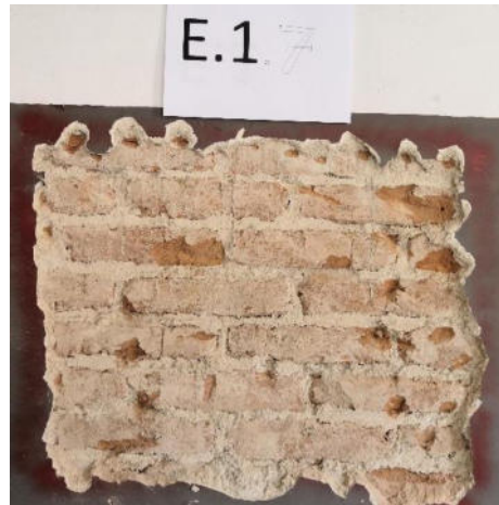
Figura 4 - Muratura in mattoni pieni e malta di calce
