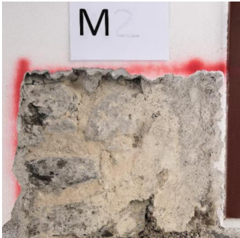
Figura 3 - Muratura in pietra a spacco con buona tessitura
