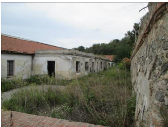
Esterno Palazzina E1
