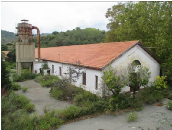
Esterno Palazzina E
