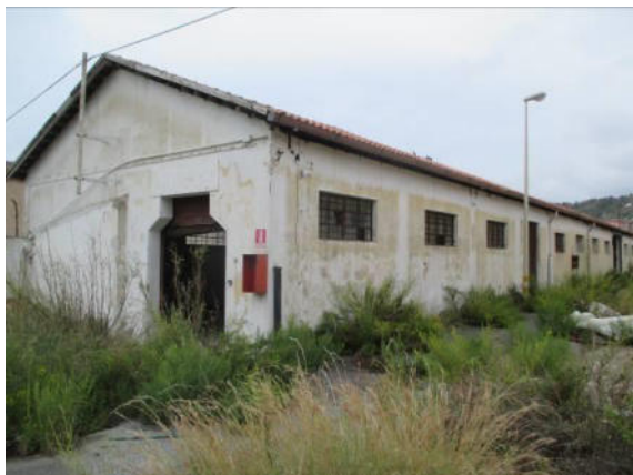
Esterno Palazzina G
