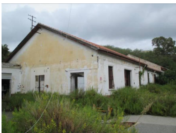
Esterno Palazzina C (porzione)
