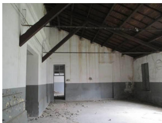
Interno Palazzina C (porzione)
