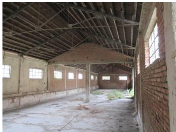
Interno Palazzina G
