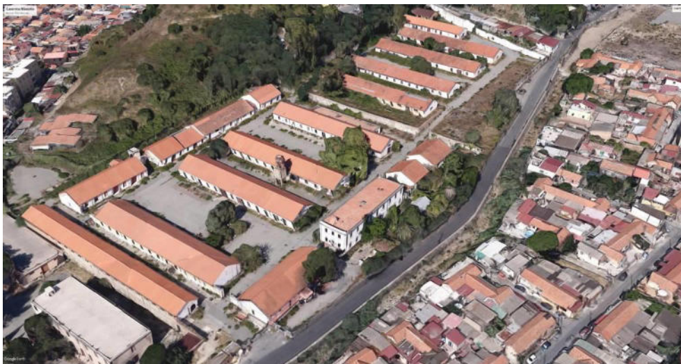
Vista aerea della Caserma Masotto tratta da Google Earth Pro (2015)
