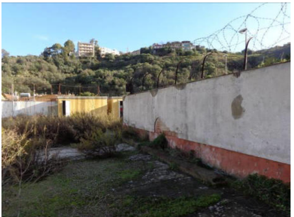
5. Locale Gruppo Elettrogeno
