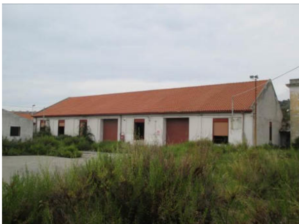
File: IMG_1232.jpg Didascalia: Ripresa Fotografica Palazzina 6 - esterno Planimetrica: No
