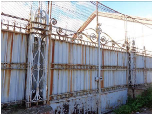
File: DSC00666.jpg Didascalia: Cancellata di Accesso
