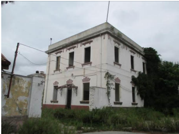
File: IMG_1188.jpg Didascalia: Ripresa Fotografica Palazzina 2 - esterno Planimetrica: No
