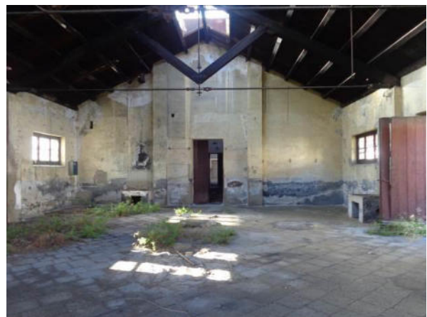
File: DSC00726.jpg Didascalia: Ripresa Fotografica Magazzino 1 - Interni Planimetrica: No
