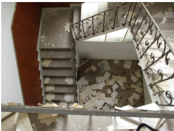
File: IMG_1333.jpg Didascalia: Ripresa Fotografica Palazzina 2 – vano scala Planimetrica: No
