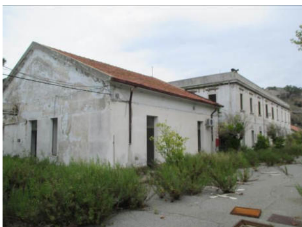
File: IMG_1284.jpg Didascalia: Ripresa Fotografica Palazzina 3 - esterno Planimetrica: No
