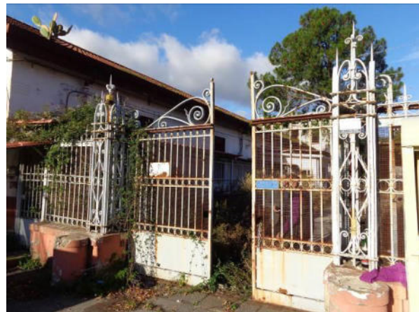
File: DSC00667.jpg Didascalia: Cancellata di Accesso
