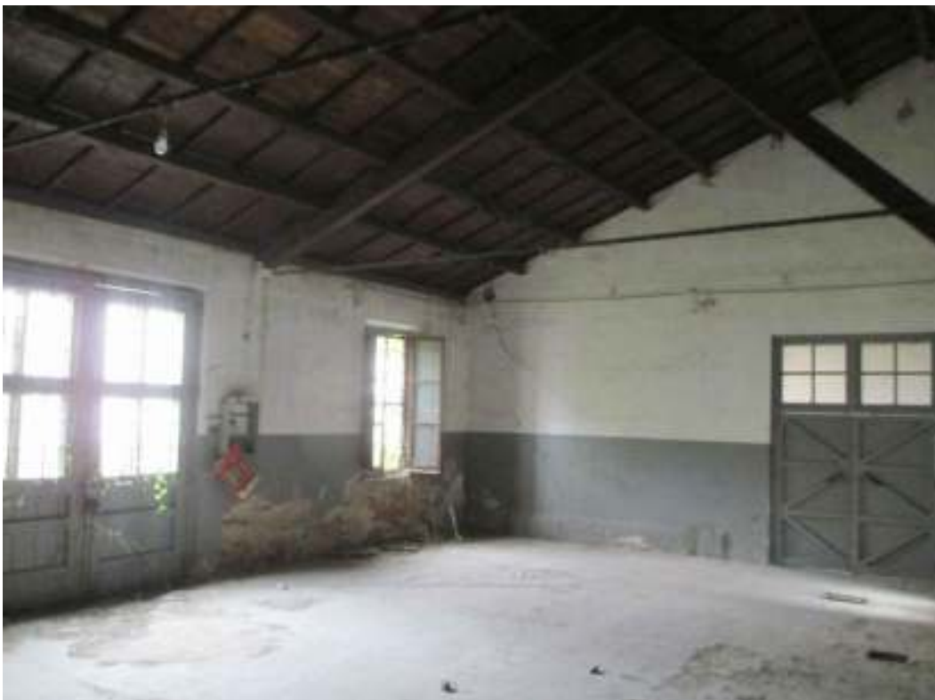
Palazzina C Ambiente interno con copertura lignea ad una falda e struttura in muratura portante
