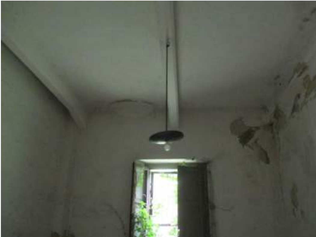
Palazzina C Ambiente interno con copertura piana realizzata con travi in C.A.
