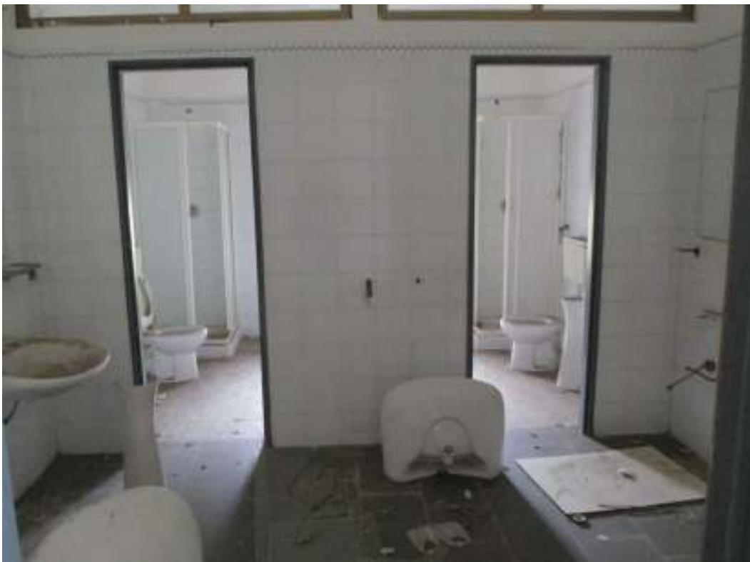
Palazzina N.1 L'immagine mostra i servizi igienici, anch'essi in totale stato di abbandono con alcuni sanitari divelti a causa delle vandalizzazioni.
