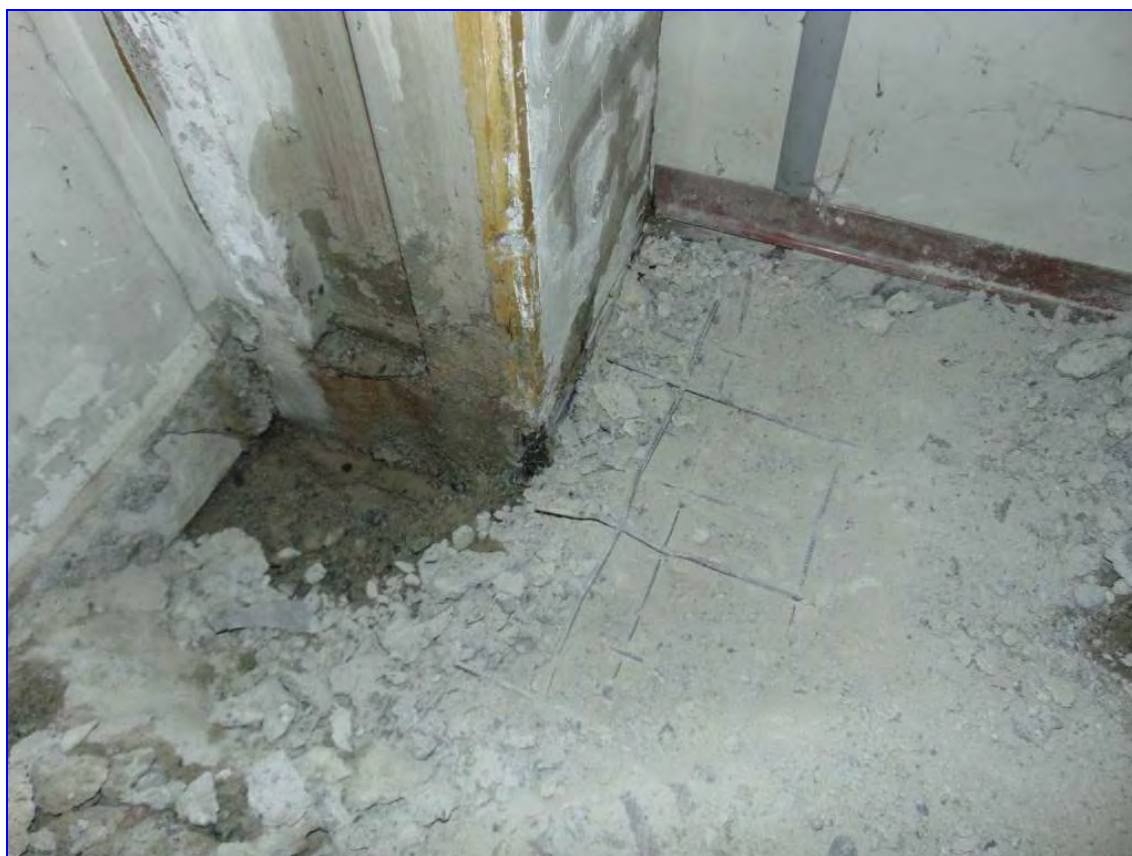
Demolizione della pavimentazione per permettere l'accesso alla fondazione
