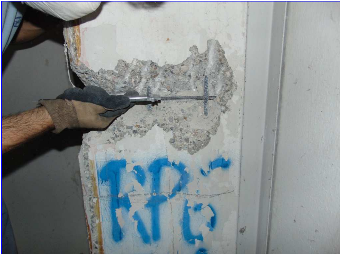
Rilievo Pilastro RP 6
