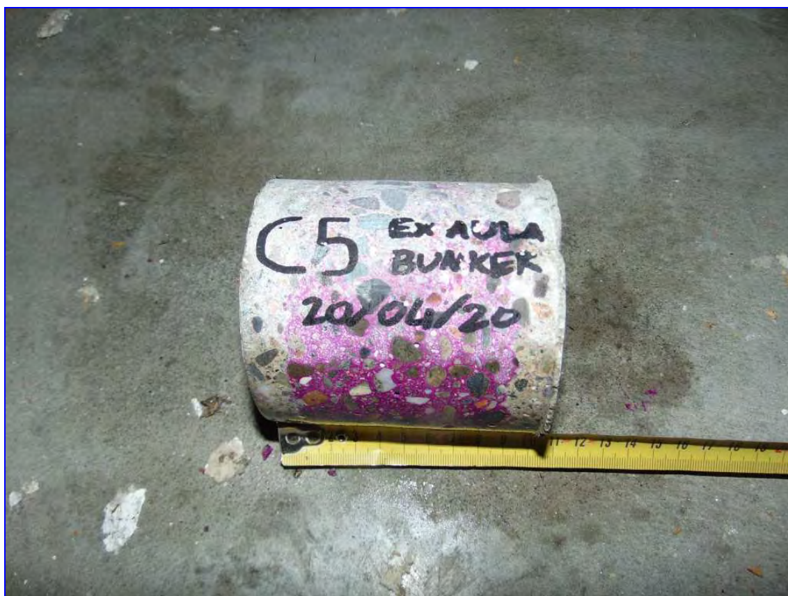
Campione C 5 – profondità di carbonatazione 2 cm.
