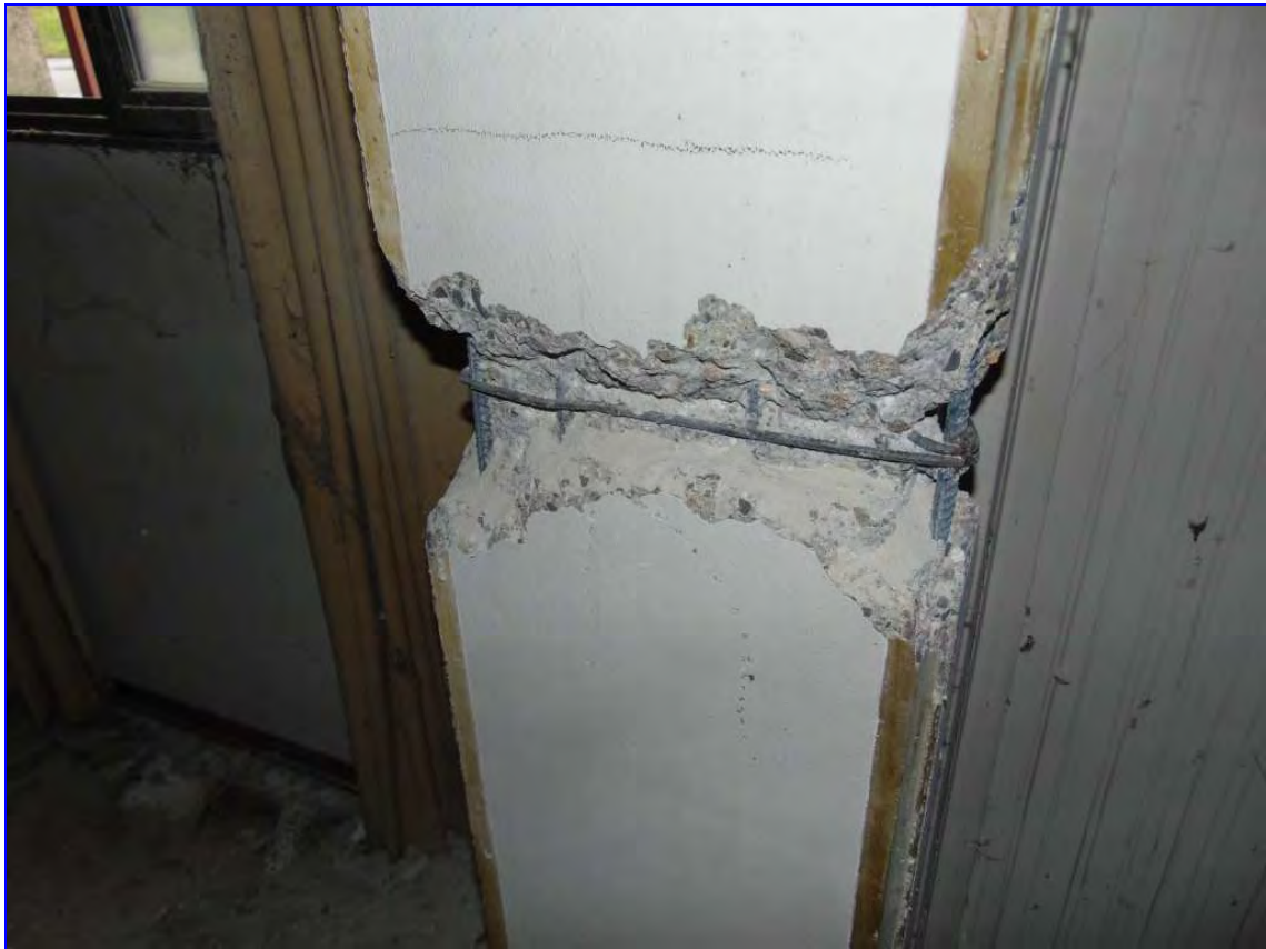
Rilievo Pilastro RP 5
