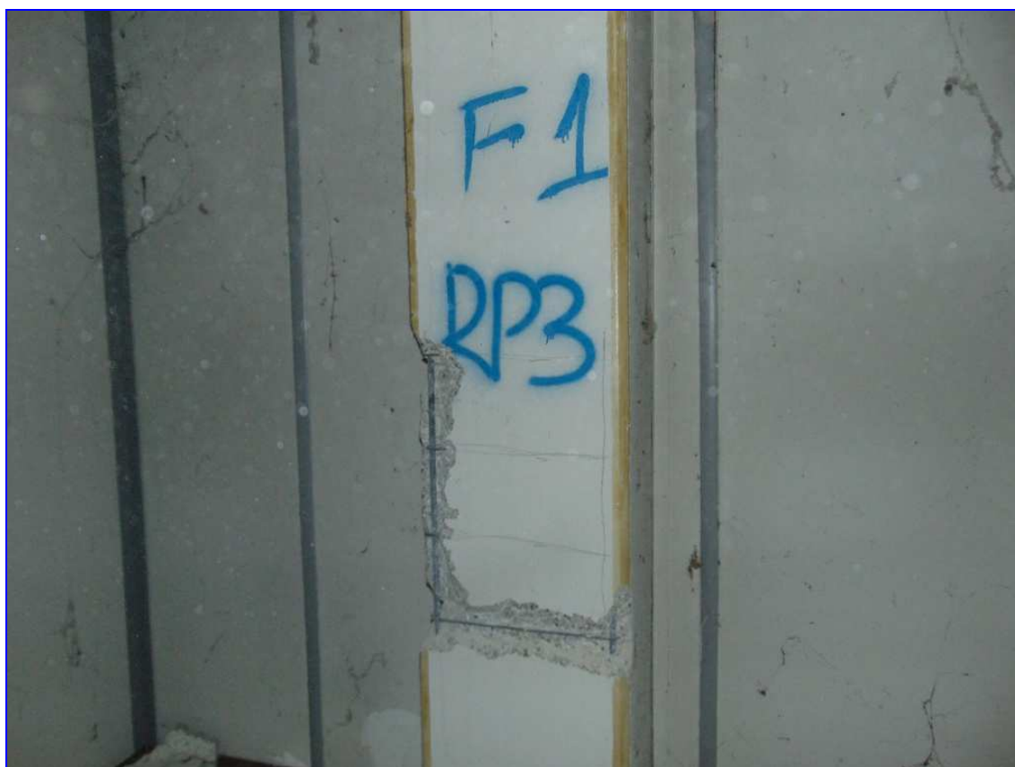
Rilievo Pilastro RP 3
