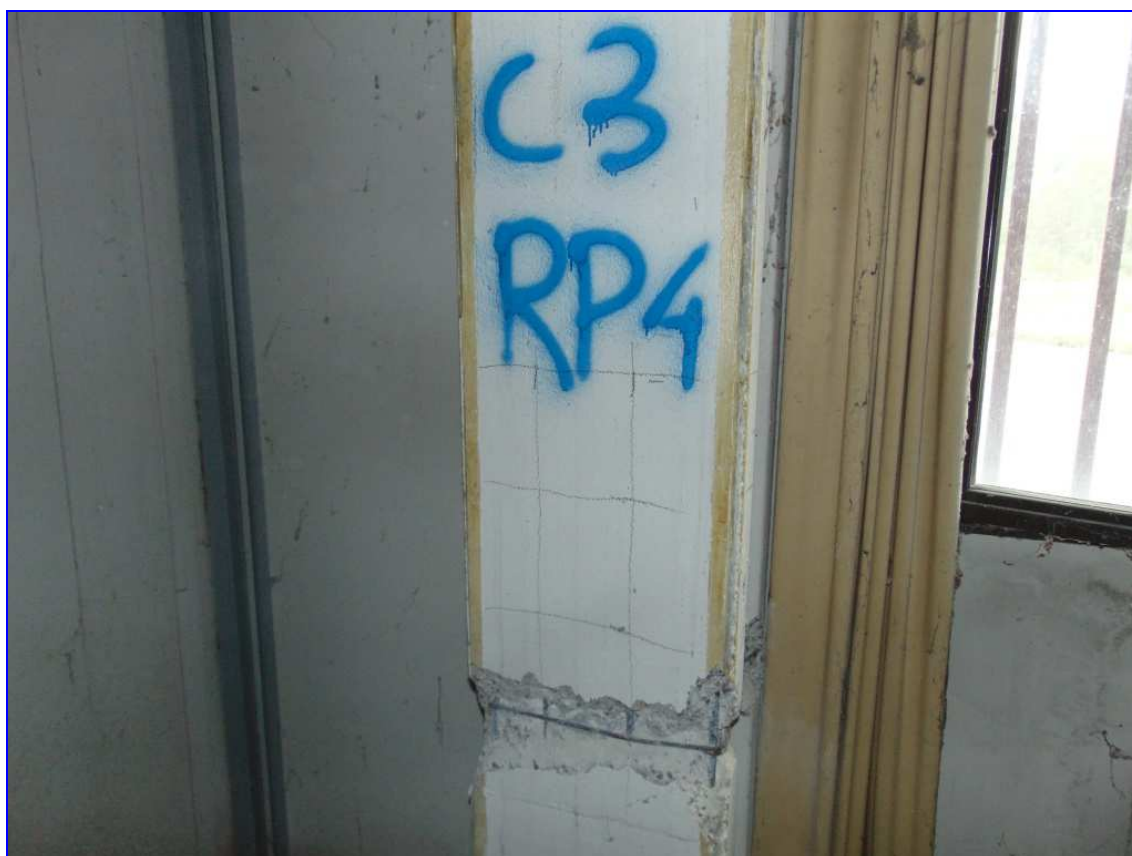
Rilievo Pilastro RP 4
