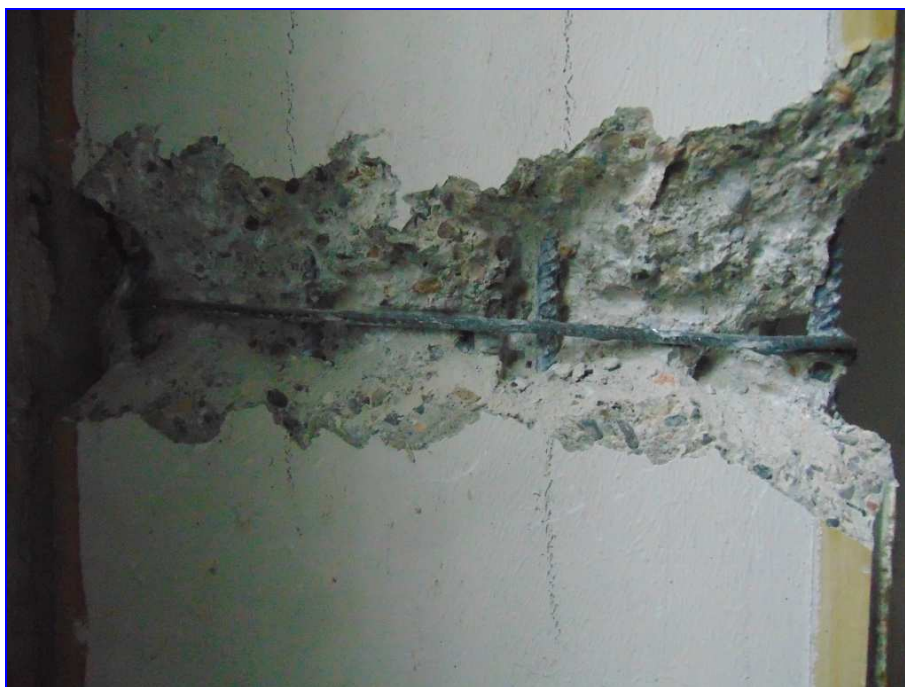
Rilievo Pilastro RP 1
