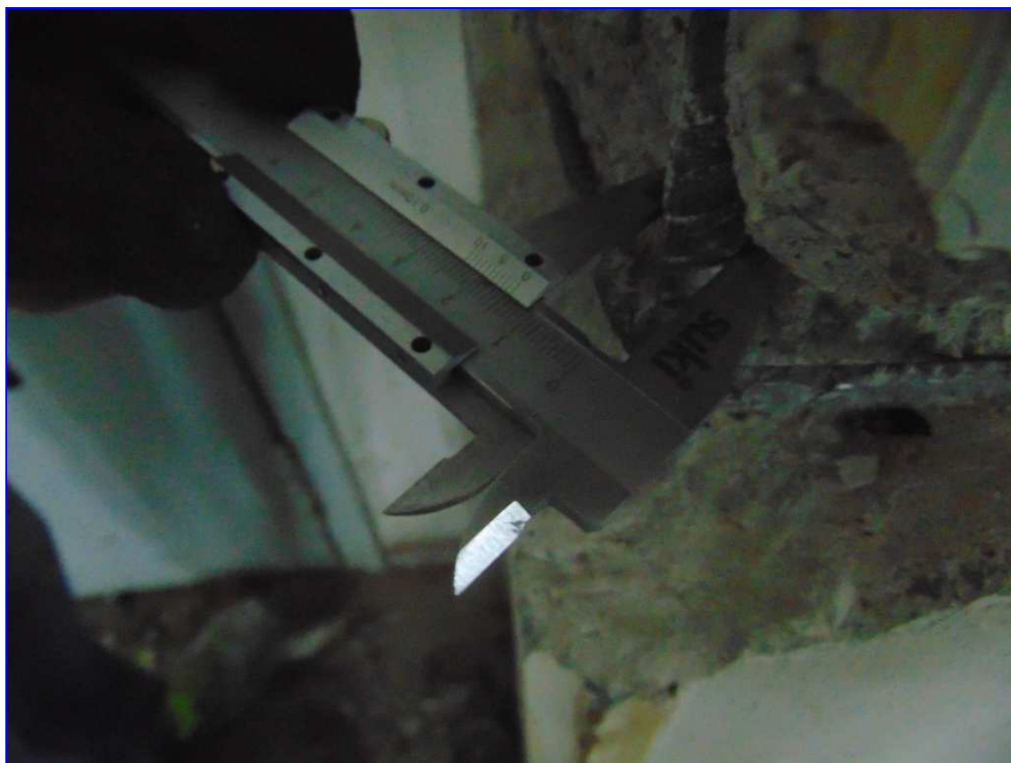
Rilievo Pilastro RP 2
