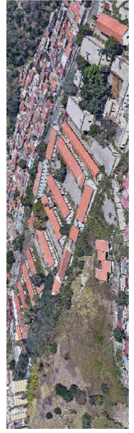
VEDUTA del compendio edilizio verso Nord
