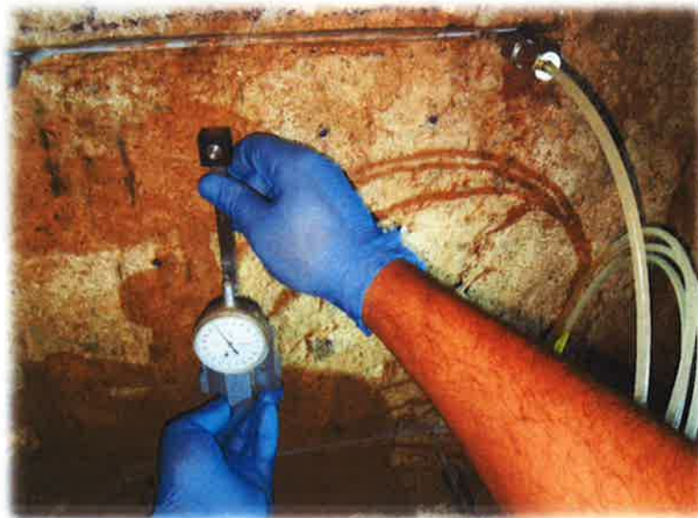
Prova n. 2 – Particolare della misura con deformometro
