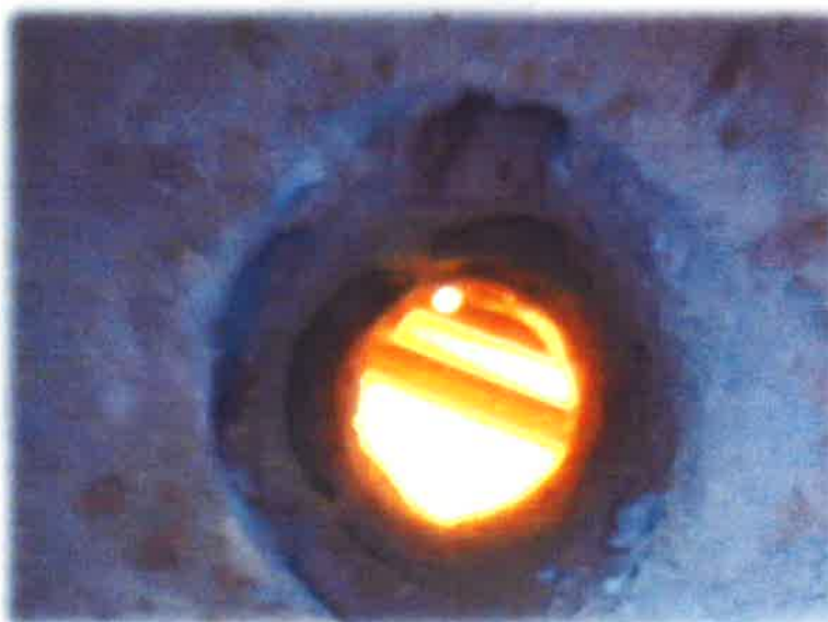
Particolare endoscopia n. 5 Muratura in laterizio forato
