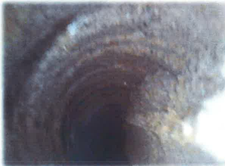
Particolare endoscopia n. 2 Muratura in pietrame disordinata con caratteristiche omogenee per tutta la profondità indagata
