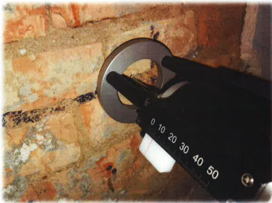
Esecuzione delle prove penetrometriche
