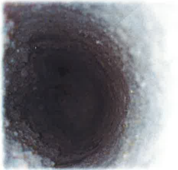
Particolare endoscopia n. 12 Muratura in pietrame disordinata con caratteristiche omogenee per tutta la profondità indagata
