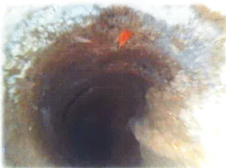
Particolare endoscopia n. 4 Muratura in pietrame disordinata con caratteristiche omogenee per tutta la profondità indagata
