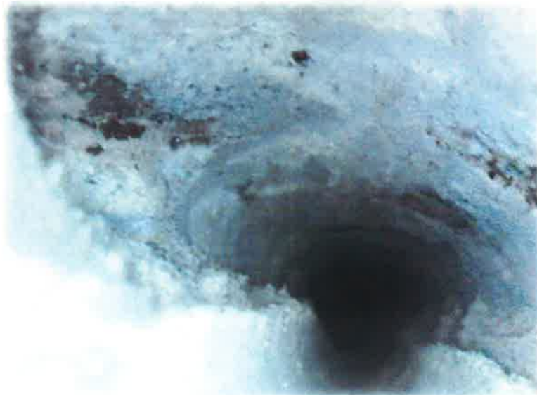
Particolare endoscopia n. 8 Muratura in pietrame disordinata con caratteristiche omogenee per tutta la profondità indagata
