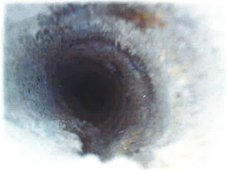
Particolare endoscopia n. 11 Muratura in pietrame disordinata con caratteristiche omogenee per tutta la profondità indagata
