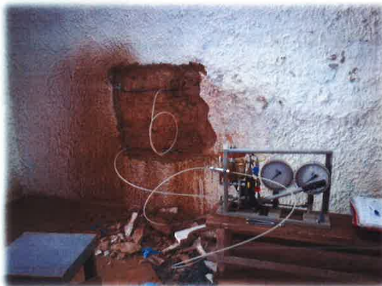
Prova n. 2 – Esecuzione della prova con doppio martinetto
