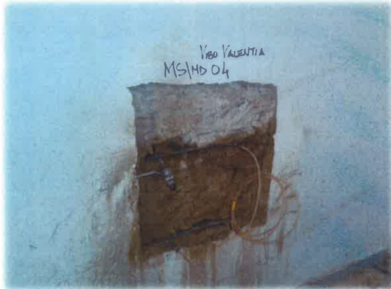
Prova n. 4 – Esecuzione della prova con doppio martinetto
