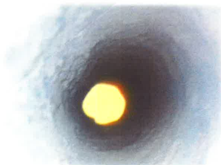
Particolare endoscopia n. 7 Muratura in pietra per tutta la profondità indagata
