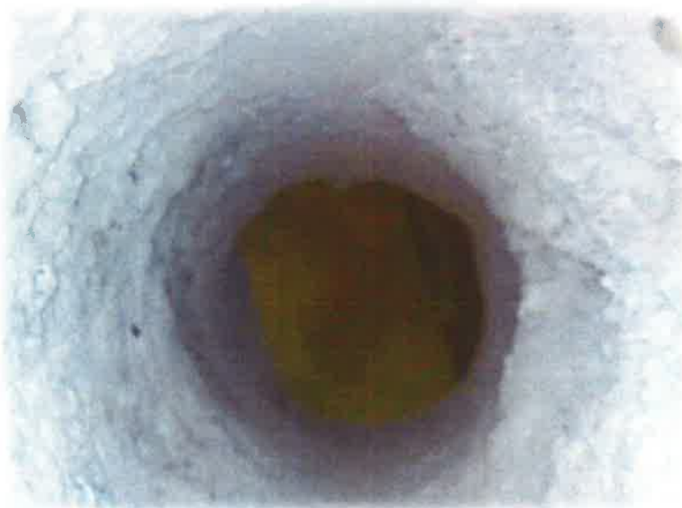
Particolare endoscopia n. 3 Muratura in pietrame disordinata con caratteristiche omogenee per tutta la profondità indagata
