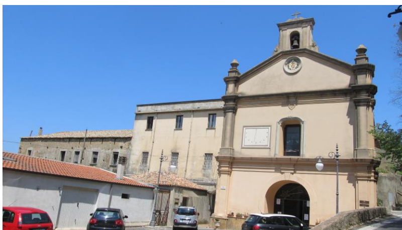
Vista frontale prospetto "Chiesa"
