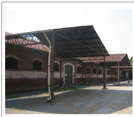
Rimessa Automezzi - Officina (F) Facciata fronte Minuto Mantenimento (E)
