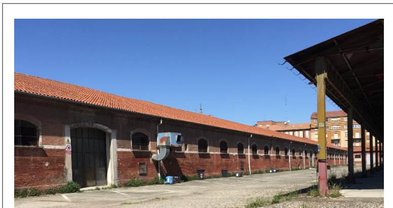
Rimessa Automezzi - Officina (F) Facciata fronte Tettoia(G)
