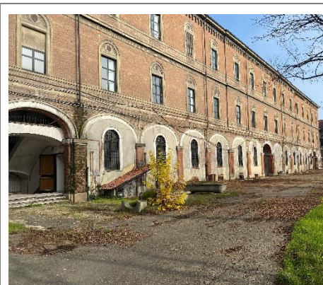
Palazzina di Comando (A) Facciata interna
