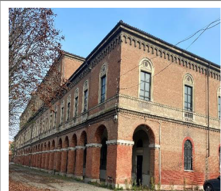
Palazzina Levante (C) Facciata interna verso piazza d'armi
