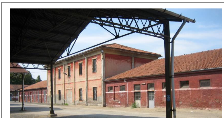
Minuto Mantenimento (E) Facciata fronte Rimessa Automezzi - Officina (F)
