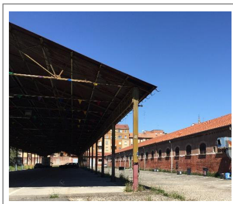
Tettoia (G) Facciata fronte Palazzina (F)
