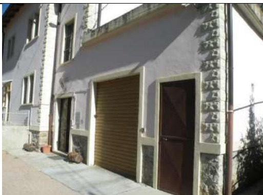
5. Particolare muratura con antiferidi
