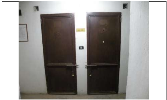
20. Accesso locale celle
