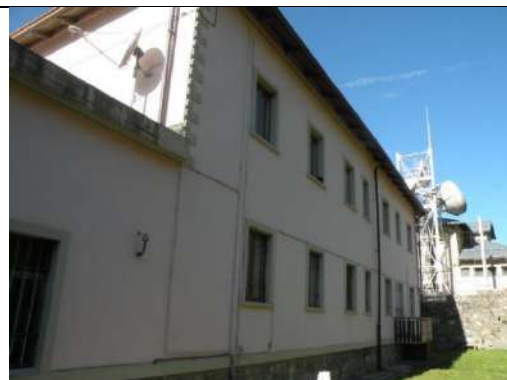
6. Prospetto lato Nord
