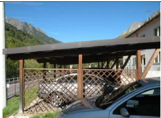
10. Vista laterale della tettoia ricovero automezzi
