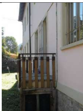
3. Vista lato Nord
