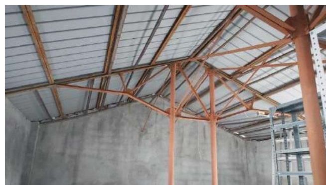
TO0714004 – Fabbricato deposito
