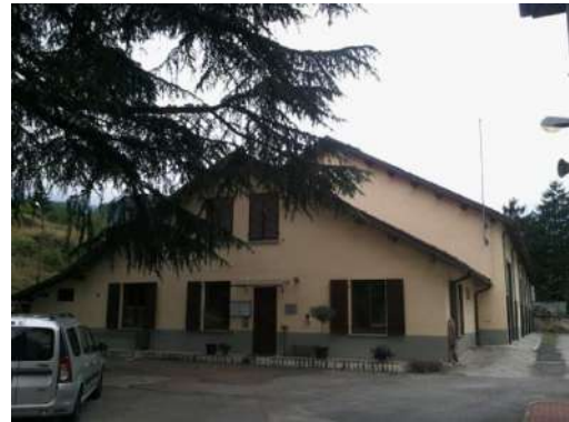
TO0714011 Capannone - Autorimessa
