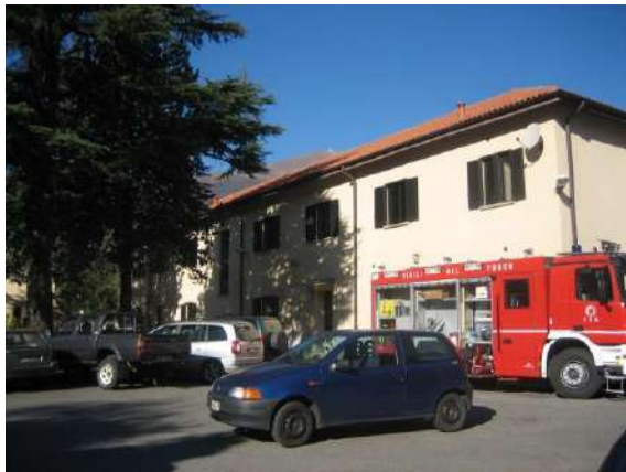
TO0714007 Fabbricato sede Distaccamento VVF-Susa
