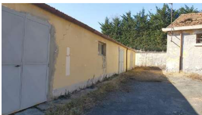
TO0714004 – Fabbricato deposito
