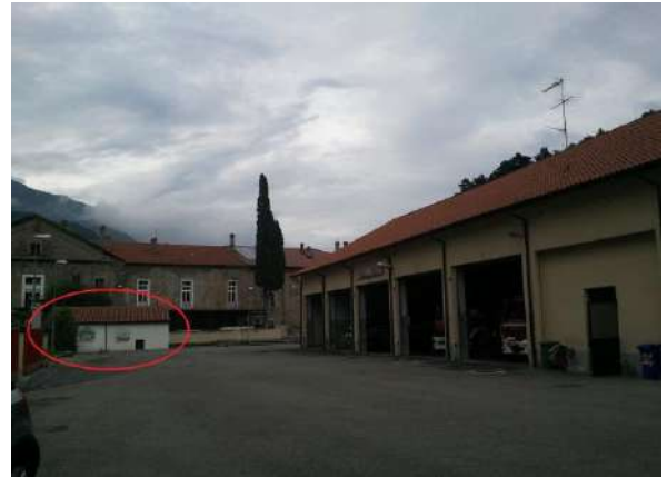
TO0714009 Basso fabbricato cabina elettrica VVF
