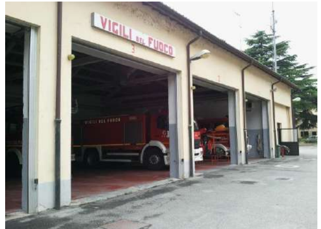
TO0714008 – Autorimessa VVF
