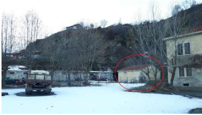
TO0714006 – Fabbricato docce
