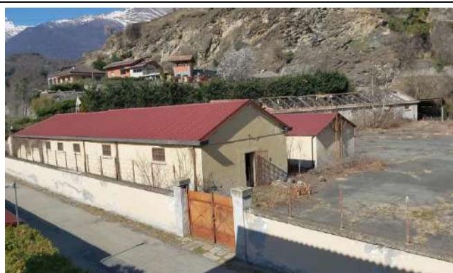
TO0714003 – Fabbricato deposito
