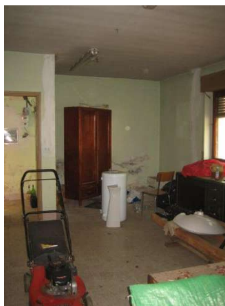
TO0038002 – Vista interna
