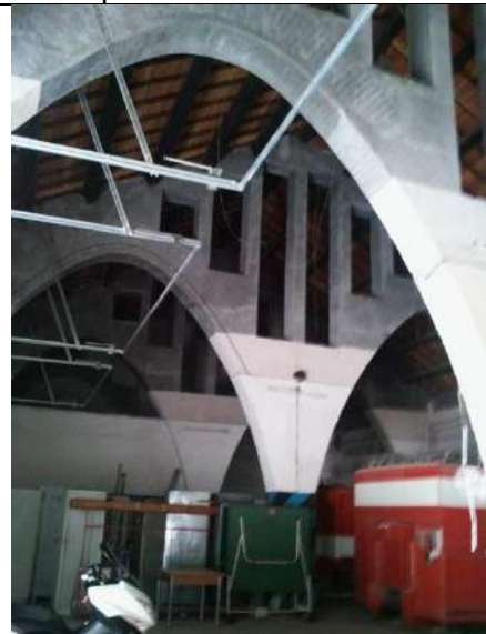
TO0714011 Capannone - Autorimessa
