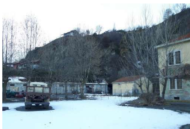
TO0714005 – Fabbricato tetto crollato
