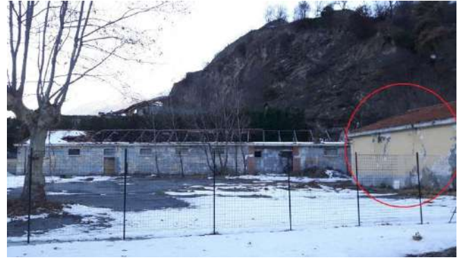
TO0714006 – Fabbricato docce
