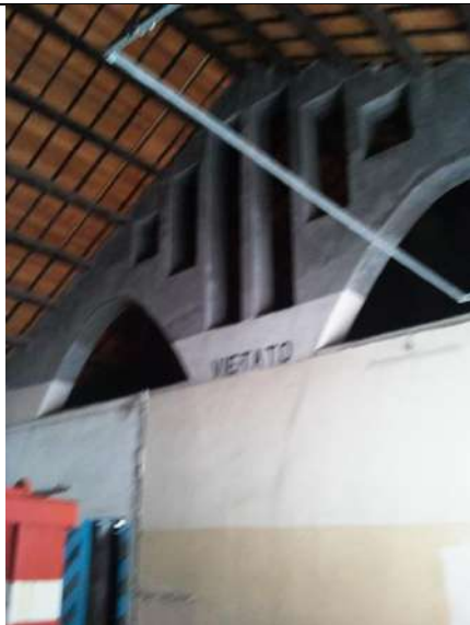
TO0714011 Capannone - Autorimessa
