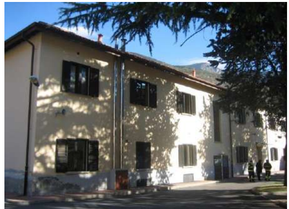
TO0714007 Fabbricato sede Distaccamento VVF-Susa
