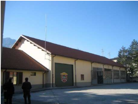
TO0714008 – Autorimessa VVF
