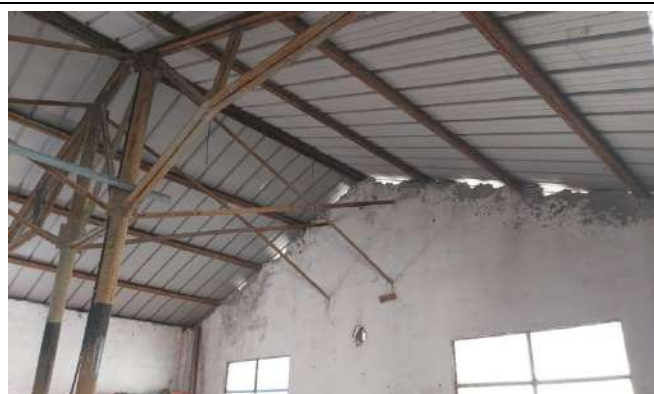
TO0714003 – Fabbricato deposito
