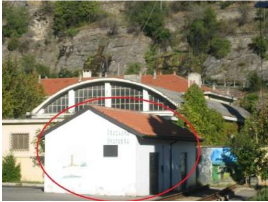
TO0714009 Basso fabbricato cabina elettrica VVF
