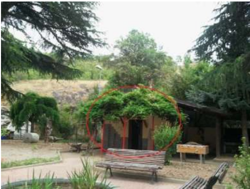
TO0714010 Basso fabbricato - forno
