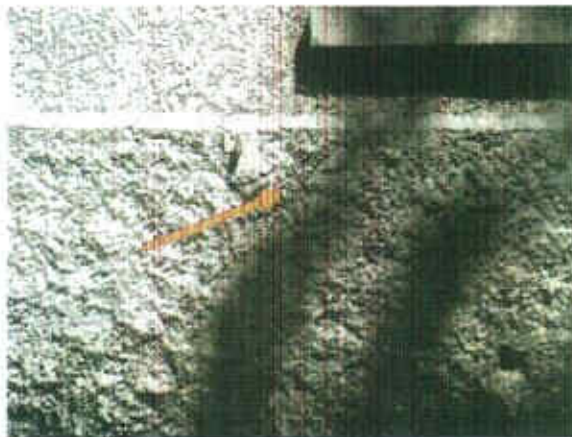
Figura 3 - lesioni passante al di sotto di una finestra
