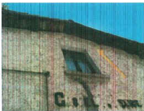
Figura 1 - lesione passante su muratura perimetrale
