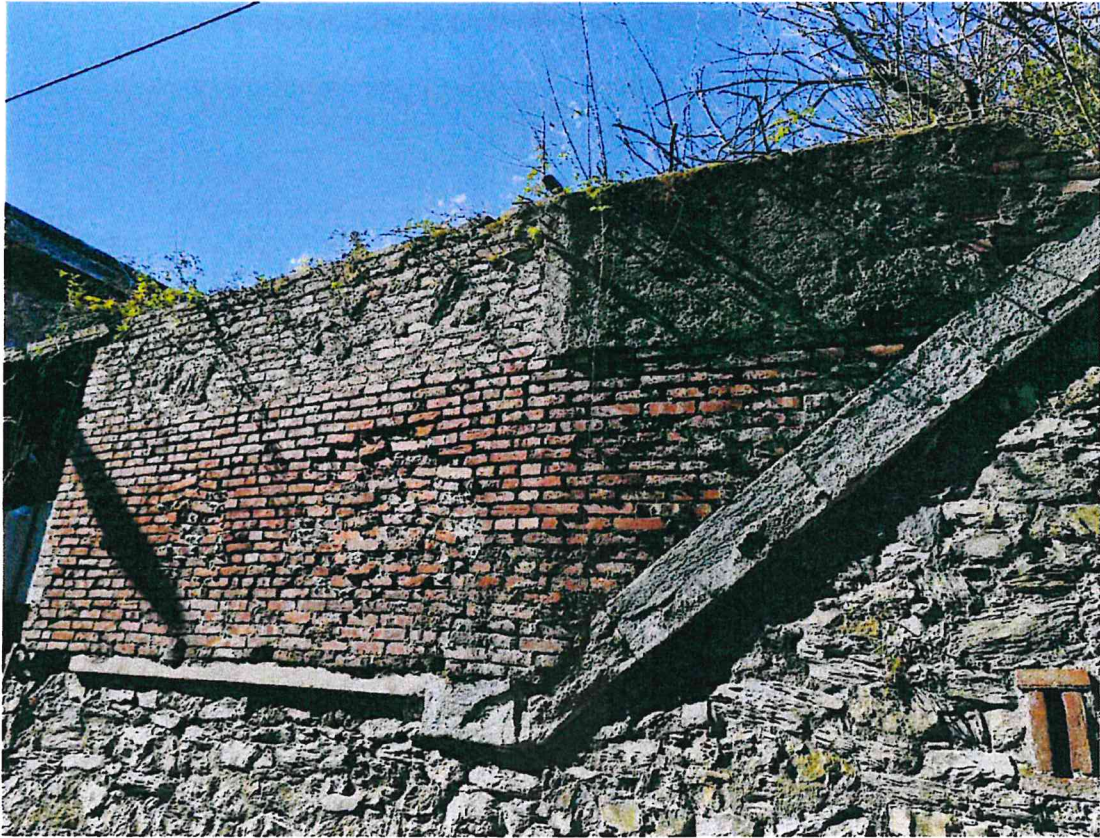
Fig. 5 – Muro perimetrale oggetto di intervento visto da Est
