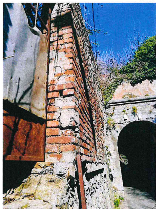
Fig. 7 – Muro perimetrale visto da Sud
