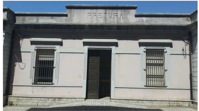
prospetto est (particolare)
