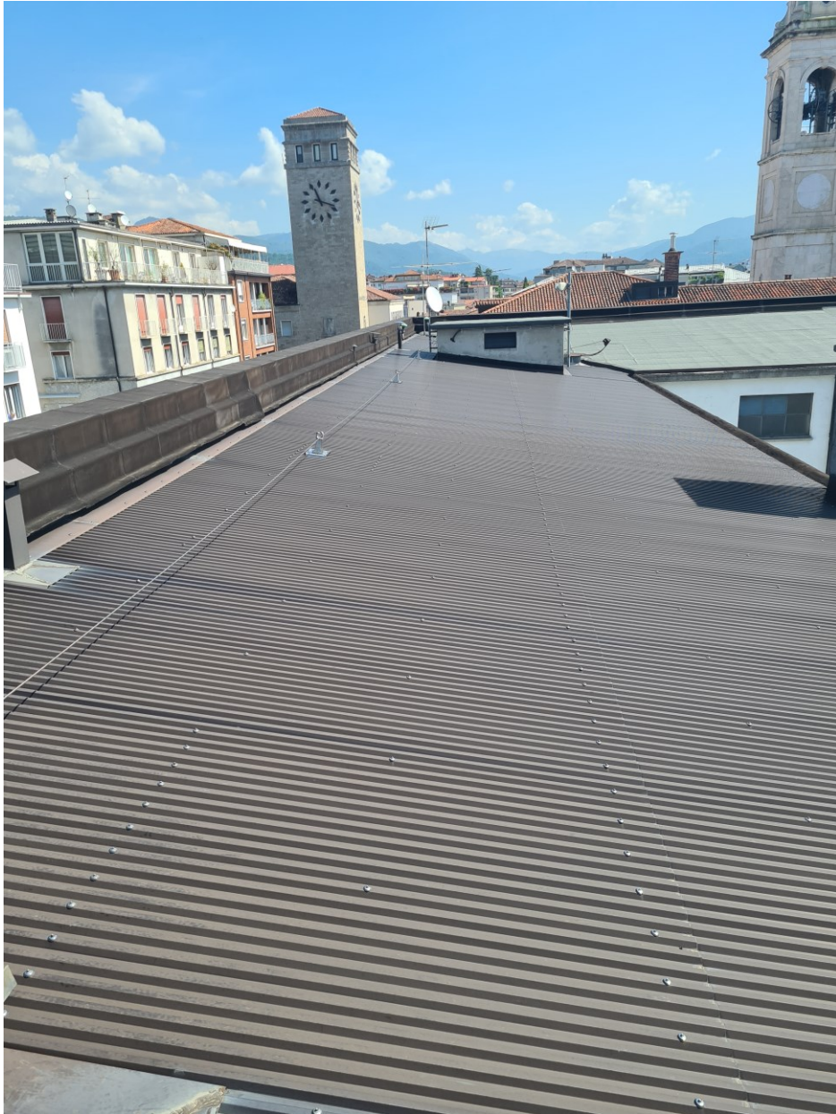
Figura 2. Vista copertura con linea vita esistente
