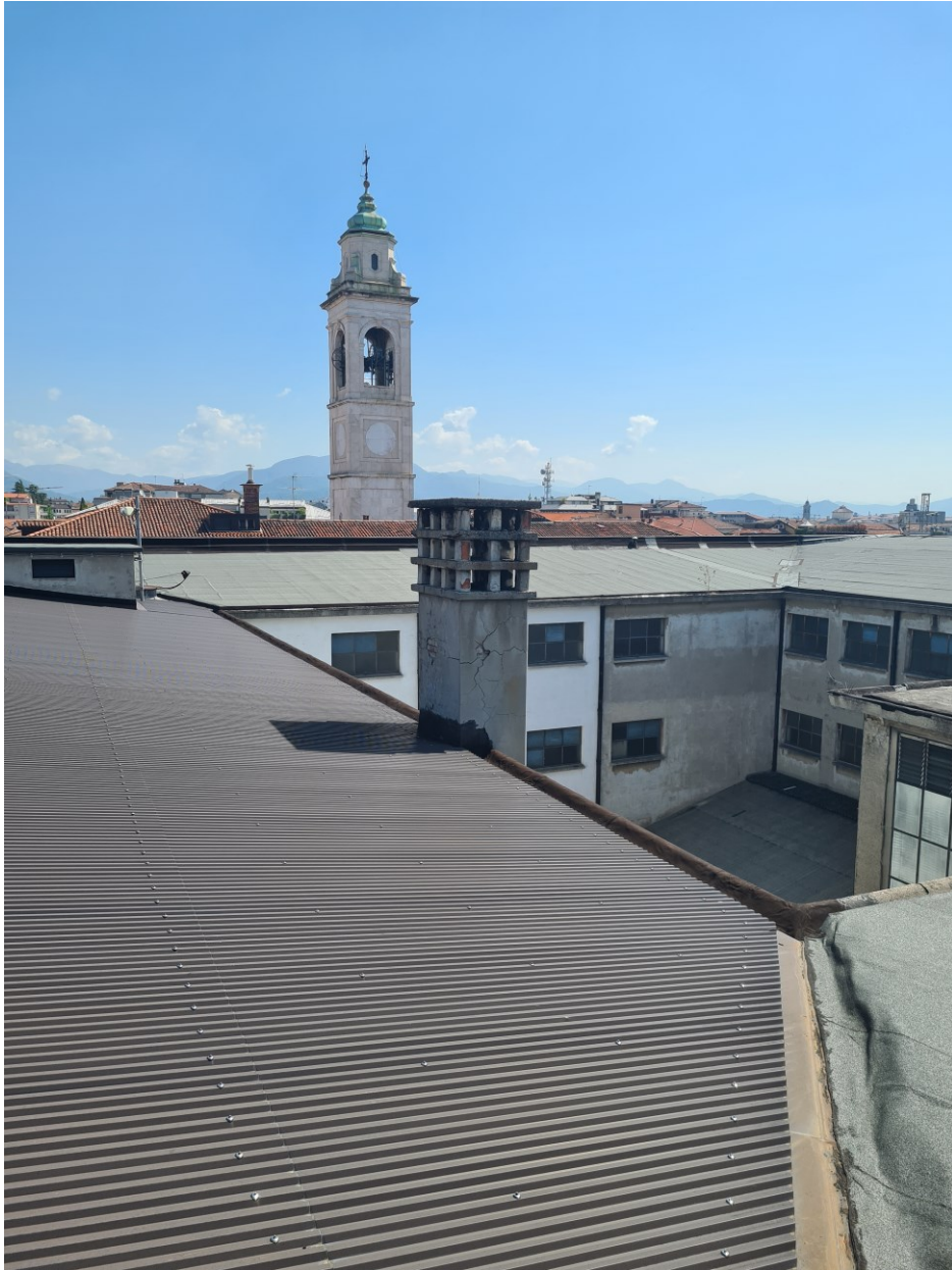
Figura 1. Vista copertura sulla corte interna
