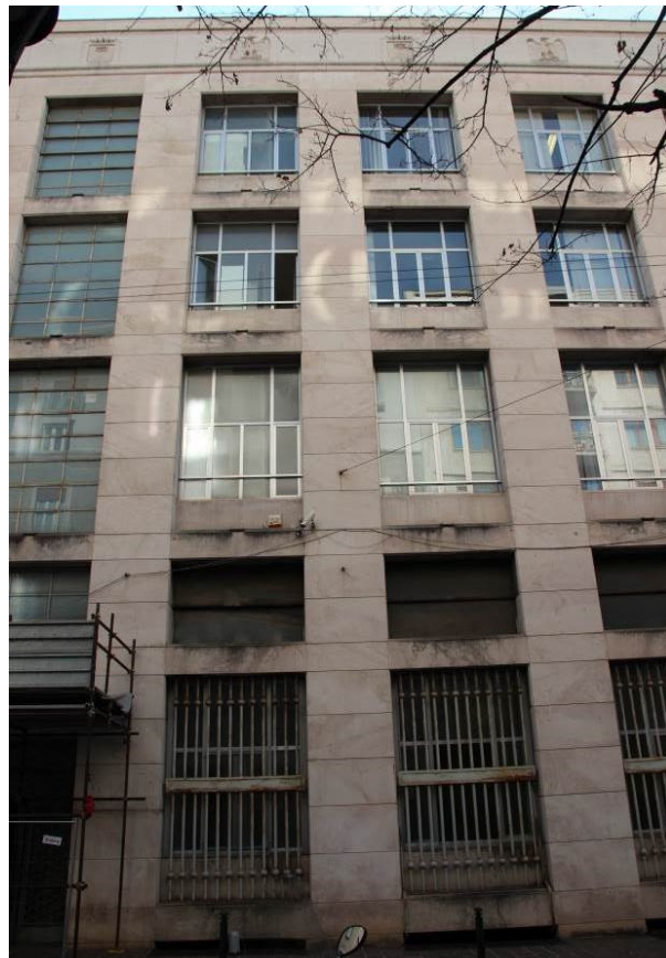
Fig. 40: Porzione centrale del prospetto su via Zelasco
