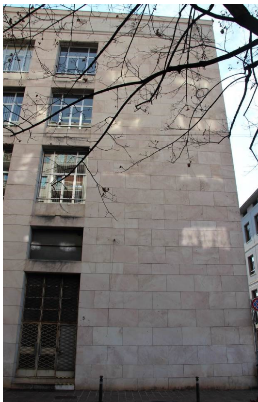
Fig. 41: Porzione destra del prospetto su via Zelasco
