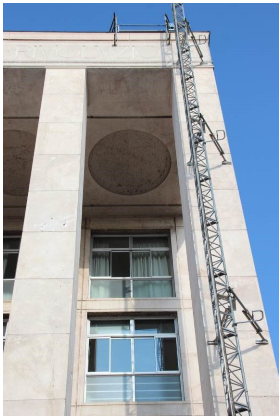
Fig. 10: Parte superiore dell'11° e 12° pilastro
