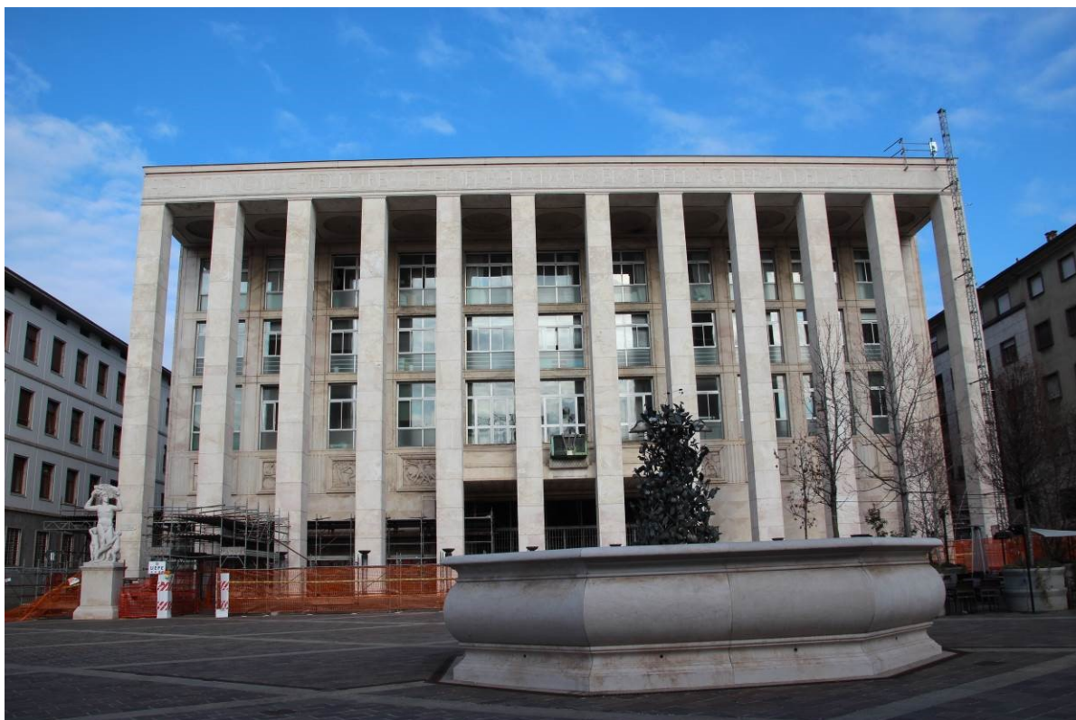
Fig. 2: Fronte sud-est visto da Piazza della Libertà
