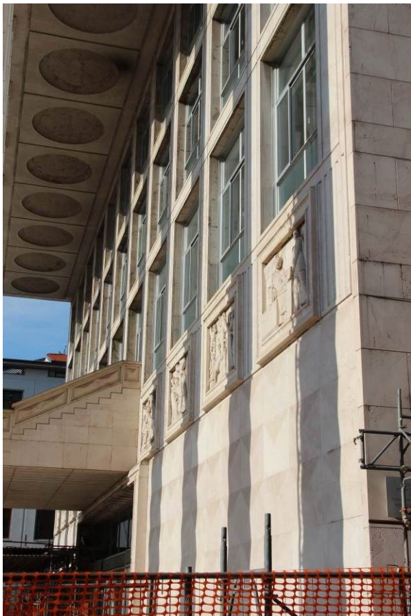
Fig. 18: Prospetto sud-est sotto il portico
