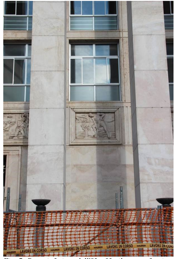
Fig. 7: Parte inferiore dell'8° e 9° pilastro e facciata del sottoportico
