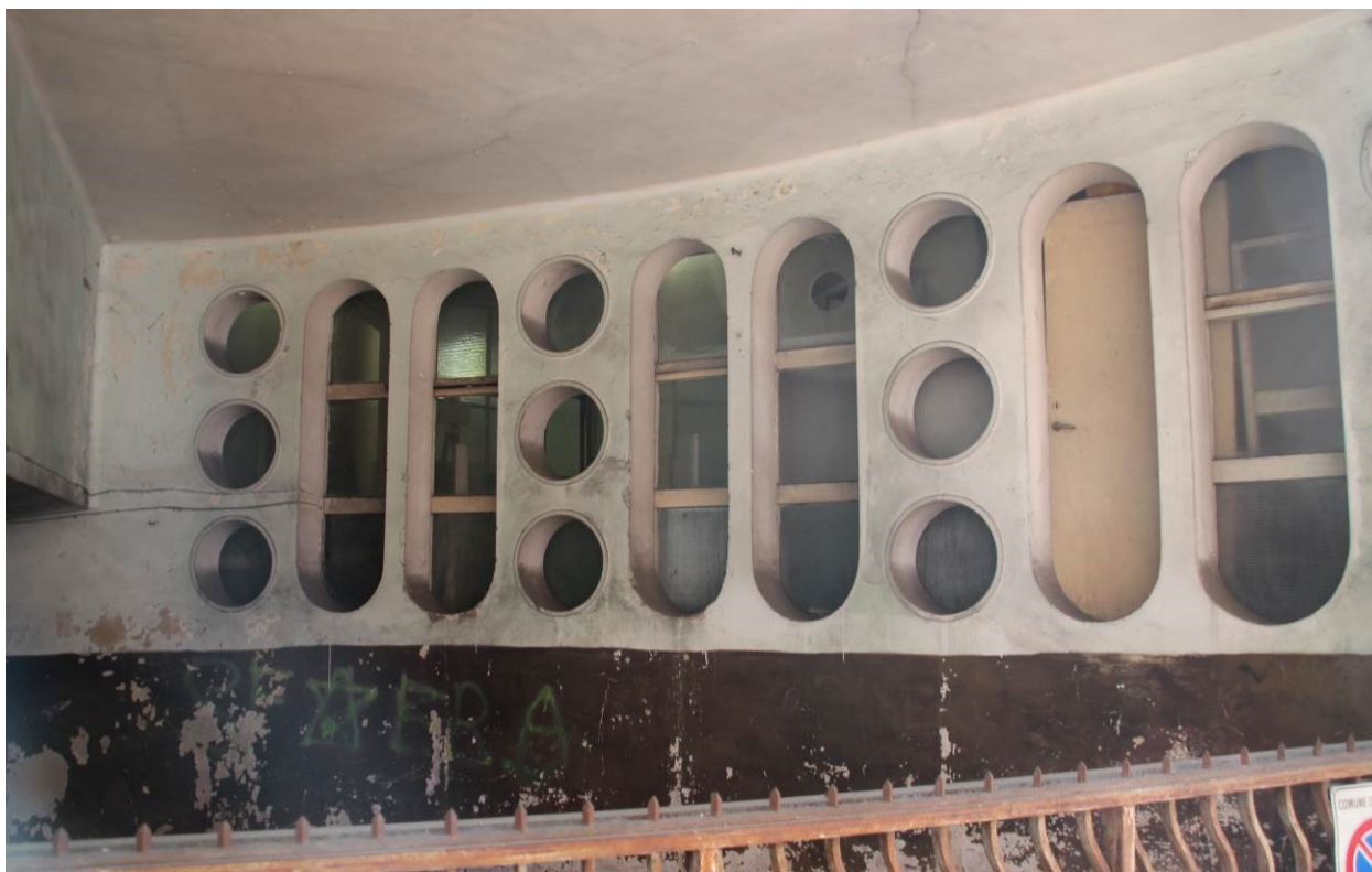
Fig. 48: Aperture in corrispondenza dell'ingresso carrabile del seminterrato
