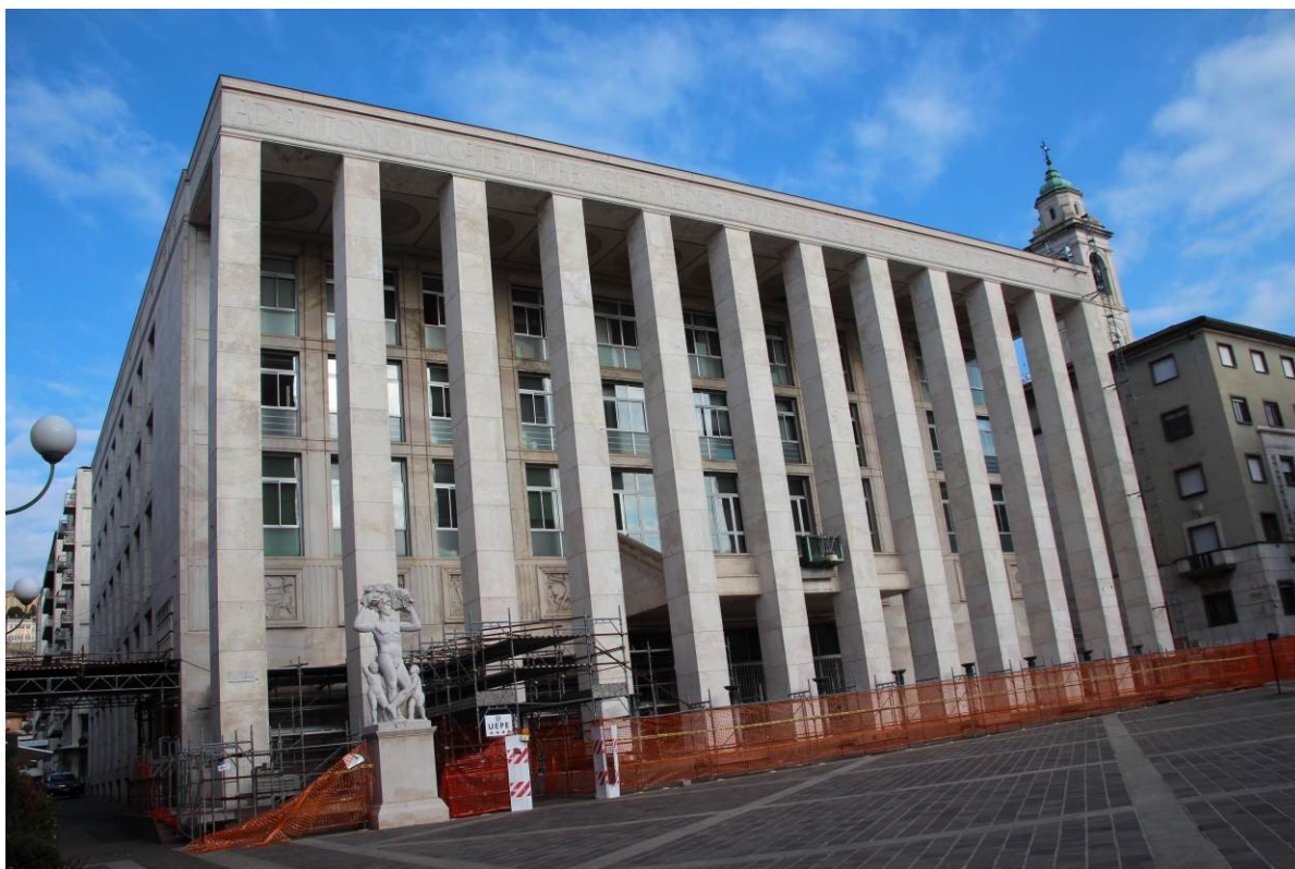
Fig. 1: Prospetto principale visto da sud
