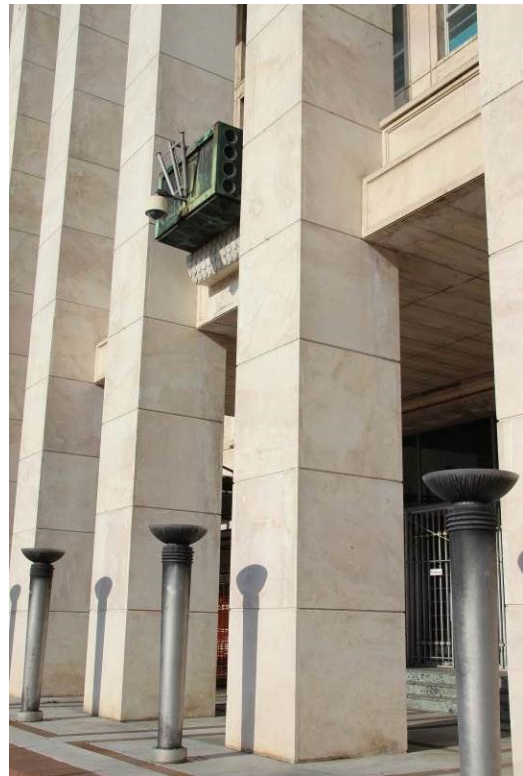
Fig. 15: Parte inferiore dei pilastri
