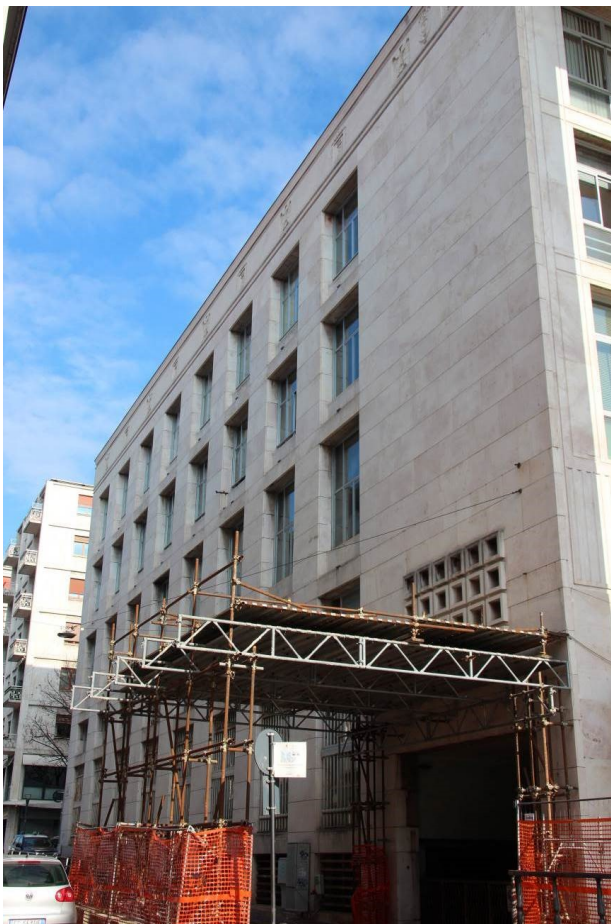
Fig. 46: Prospetto su via Montenero visto da sud
