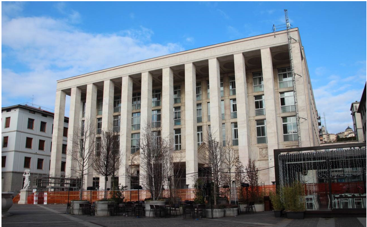
Fig. 3: Fronte sud-est visto da est
