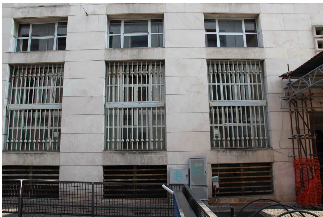
Fig. 43: Porzione inferiore centrale del prospetto su via Montenero
