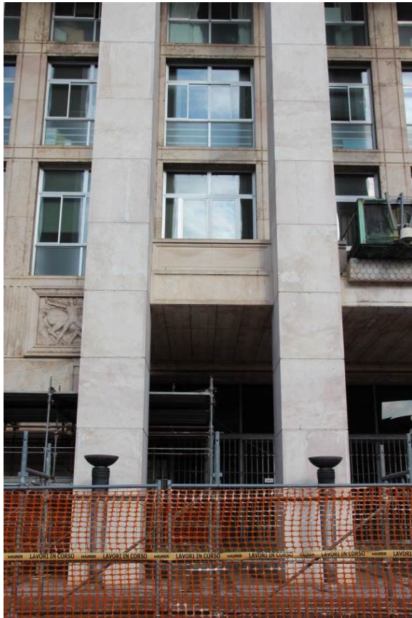
Fig. 6: Parte inferiore dei pilastri 5° e 6°
