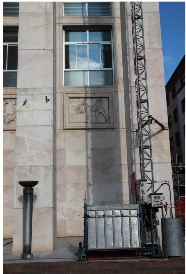
Fig. 9: Parte inferiore dei pilastri 11° e 12°
