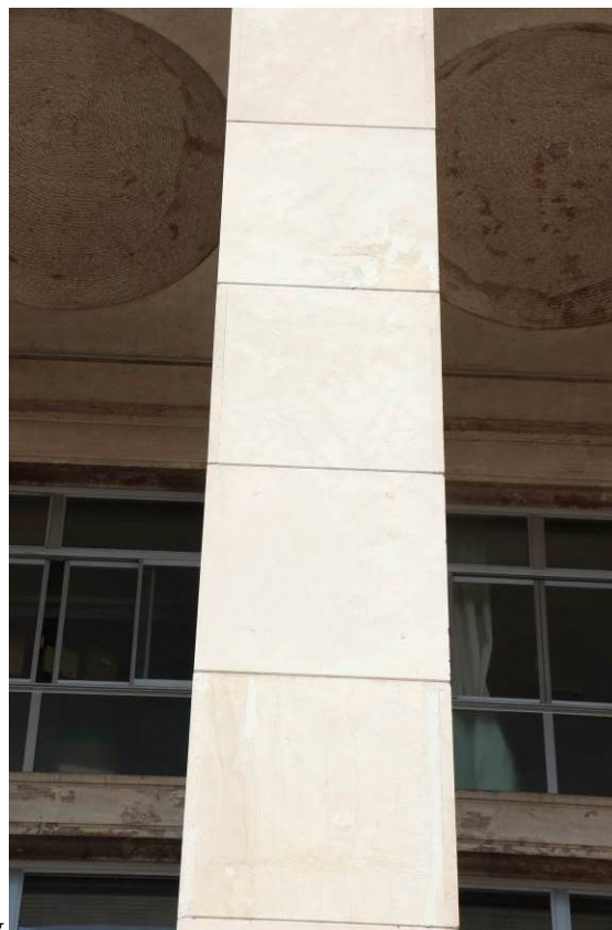
Fig. 30: Dettaglio di un pilastro ricoperto con
