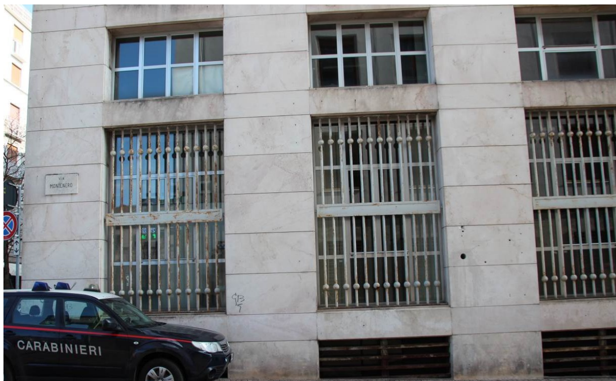
Fig. 42: Porzione inferiore sinistra del prospetto su via Montenero
