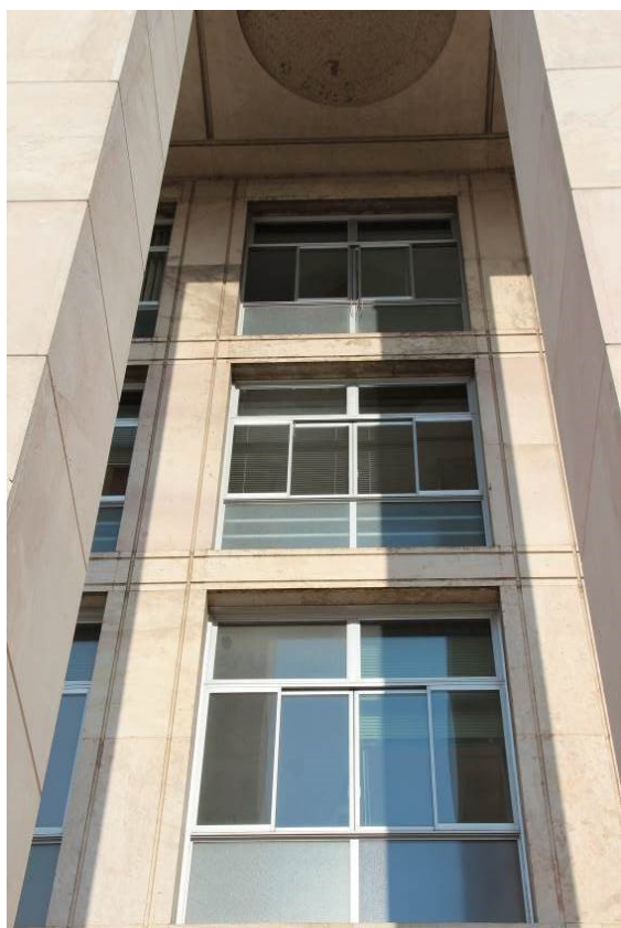
Fig. 29: Finestre del sottoportico
