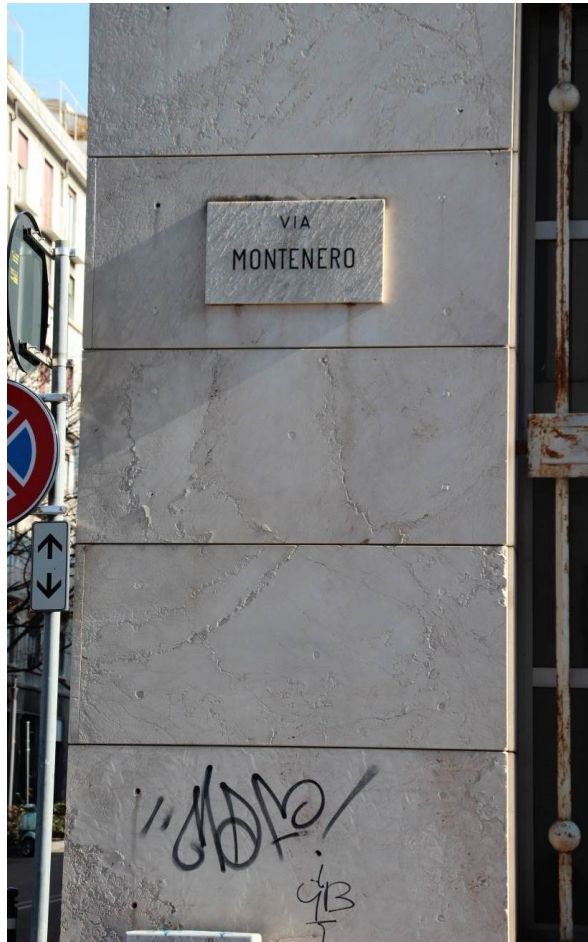
Fig. 49: Dettaglio delle lastre
