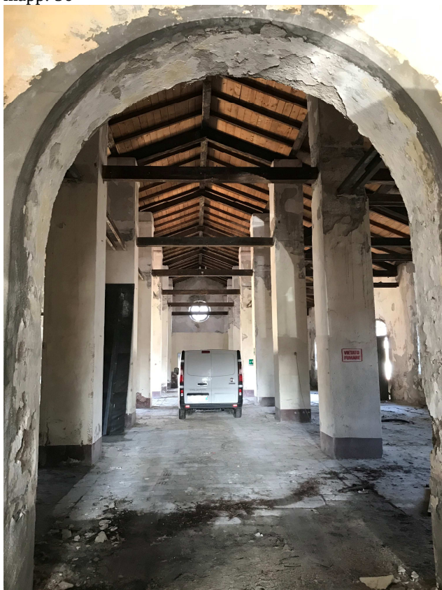
fig. 11 - interno del capannone mapp. 56 (fabbricato 1)
