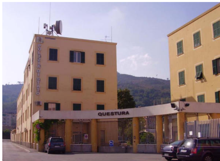
Ingresso Principale su via Partigiani
