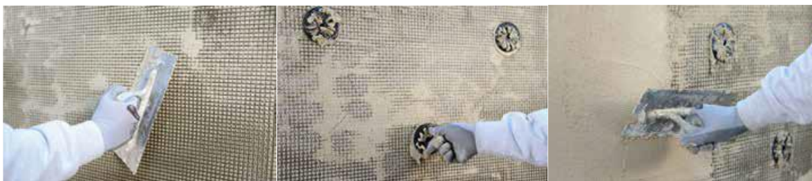
Figura 9 Esempio applicativo di reti e geomalta
