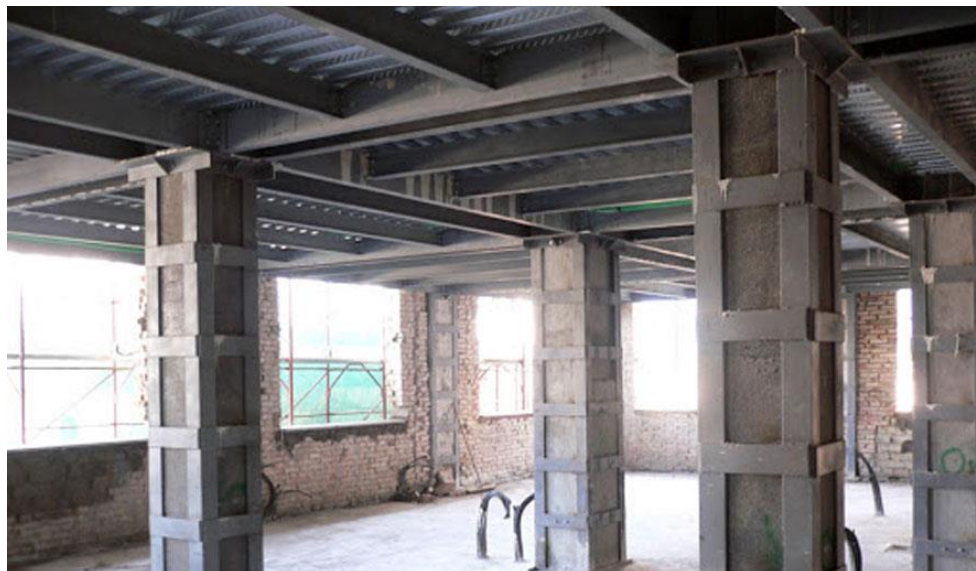
Figura 8 Esempio applicativo di calastrellature su pilastri
