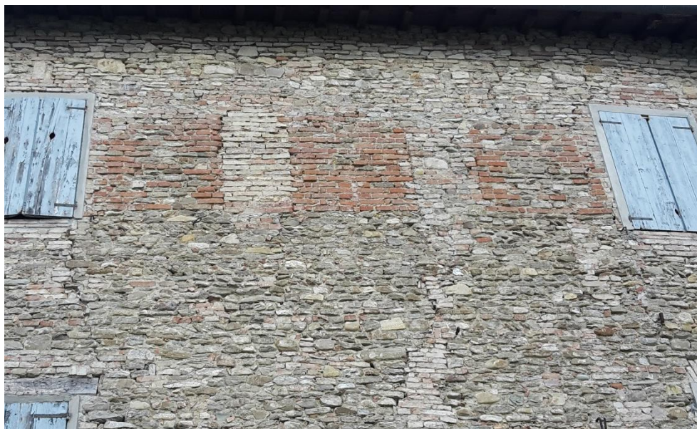
Figura 3 Esempio di intervento di scuci cuci
