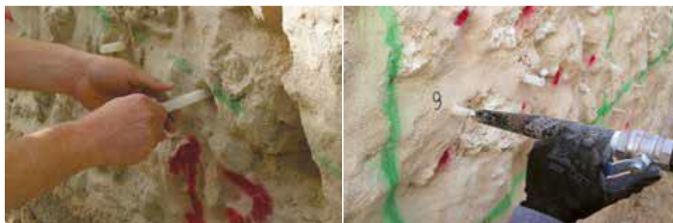
Figura 7 Esempio applicativo di iniezione di miscele leganti
