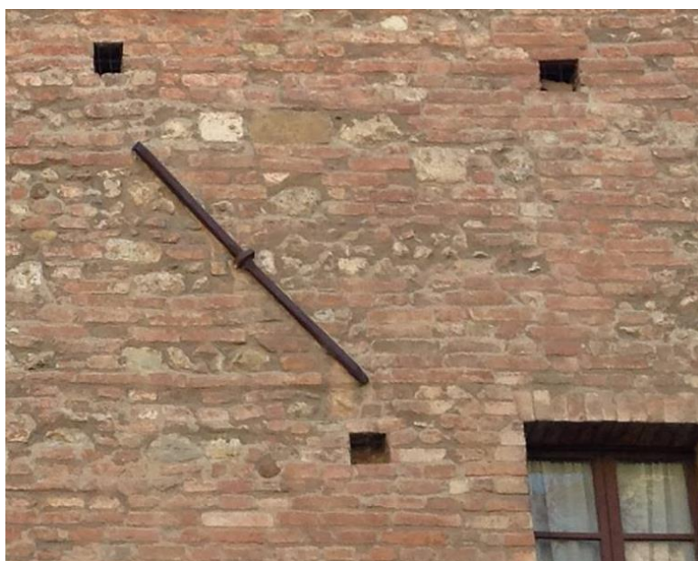
Figura 4 Esempio di catena con capochiave a paletto
