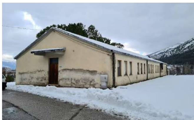
Figura 16 - Prospetto Sud e Est (vista 1)
