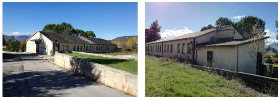
FOTO STATO DI FATTO
