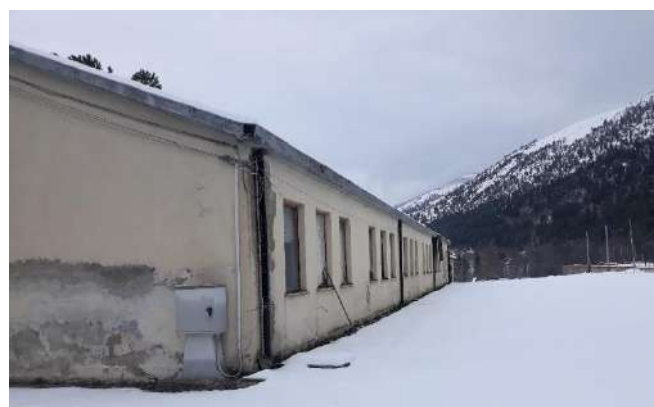
Figura 17 - Prospetto Est (vista 2)
