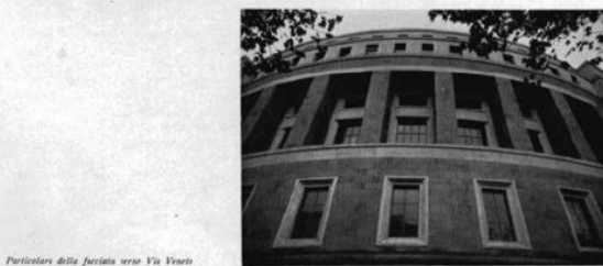
Particolare della facciata verso Via Veneto
