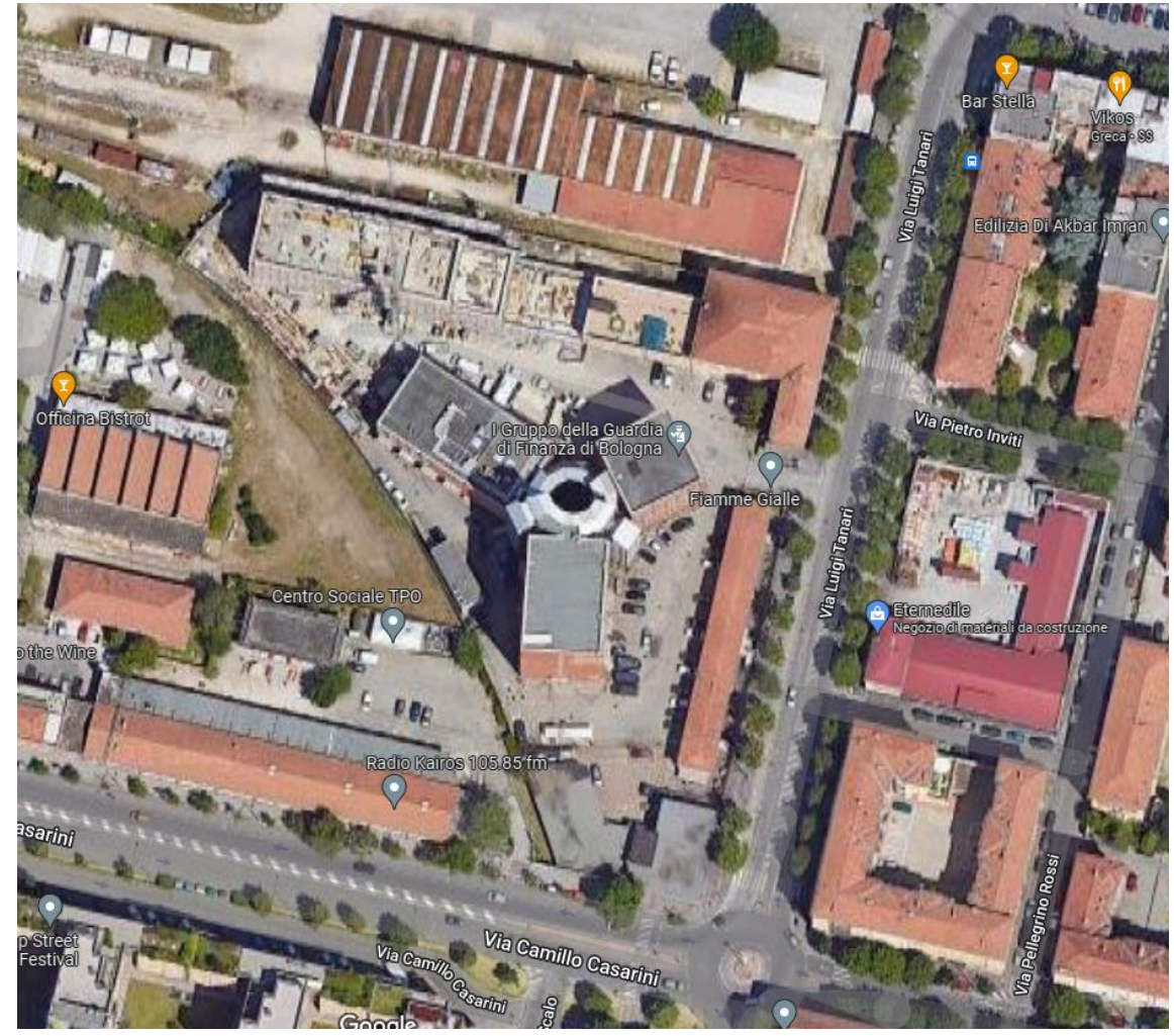
Foto Aerea dei lavori in corso d'opera
