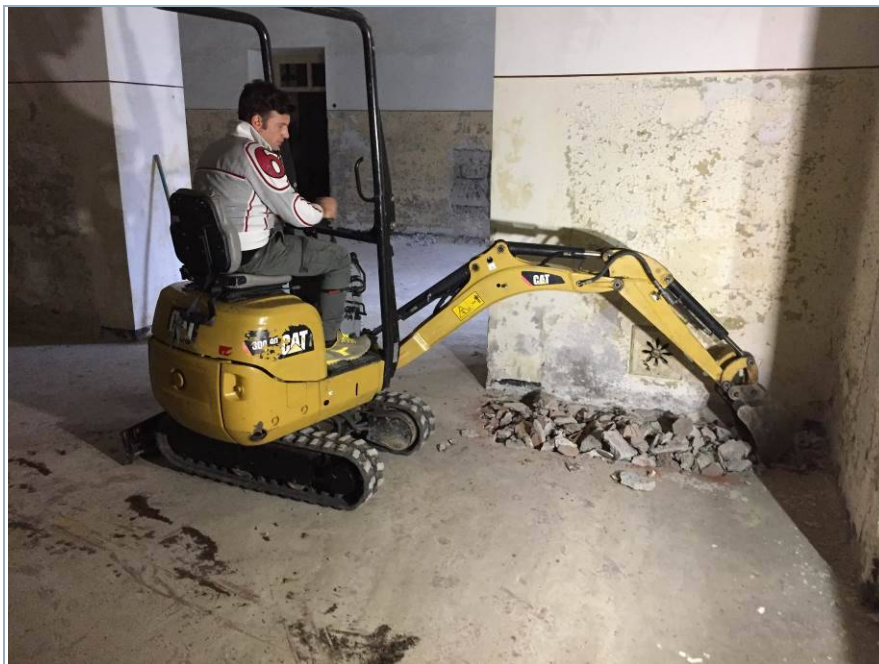
Foto panoramica dello scavo 2
