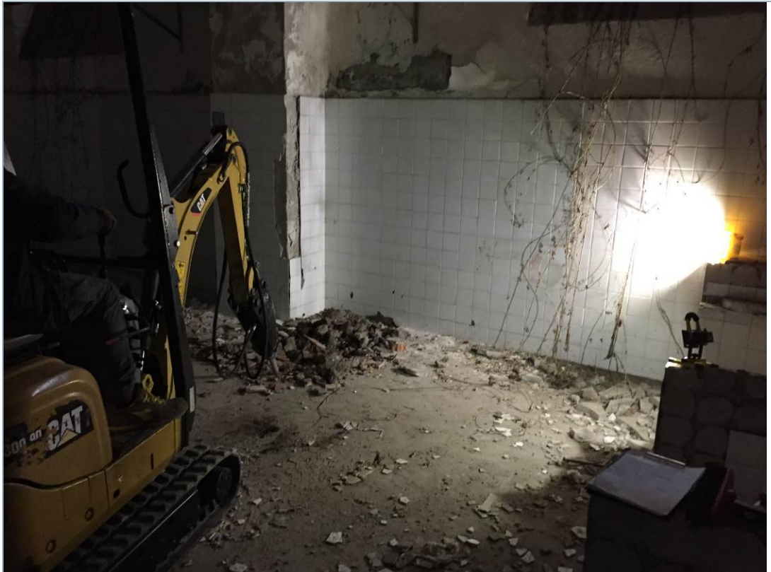
Foto panoramica dello scavo 3
