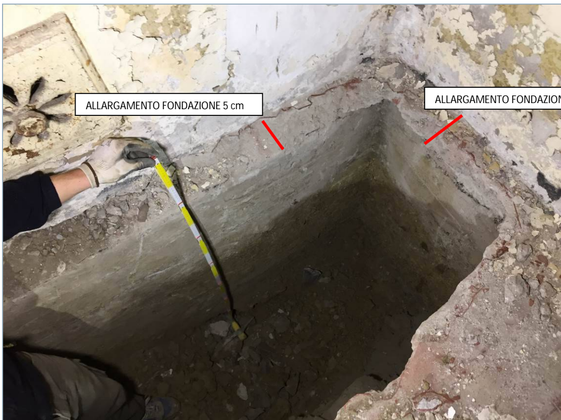
Foto dello scavo 2; visibile l'allargamento della fondazione a -0,11 cm dal piano di calpestio. L'intradosso si trova a 1,30 m dal piano di calpestio.
