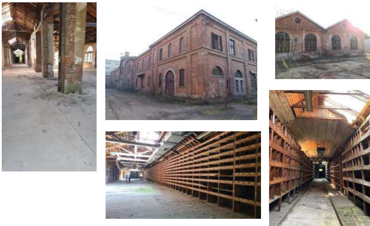
Fig. 6 – vedute di alcuni edifici storici presenti dell'area dell'ex Arsenale
