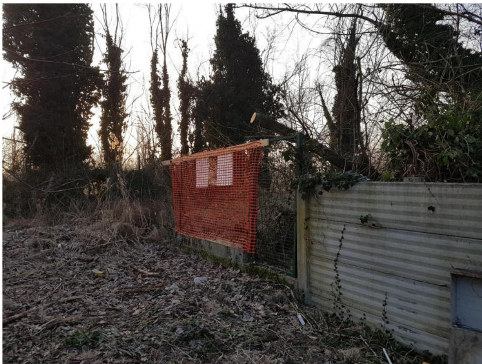
Foto5- angolo esterno della recinzione completamente divelta
