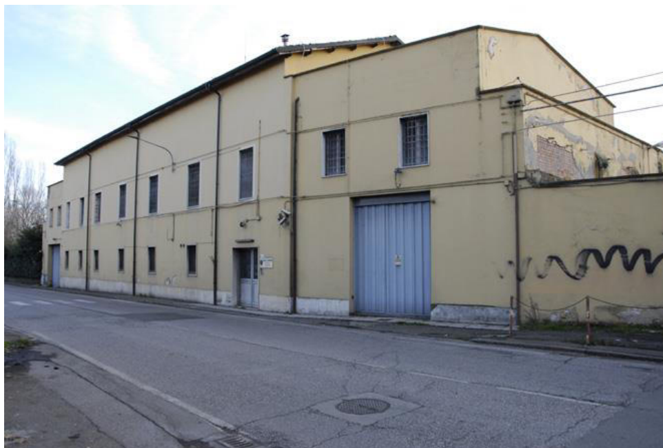
Foto3- prospetto prospiciente Strada Panni
