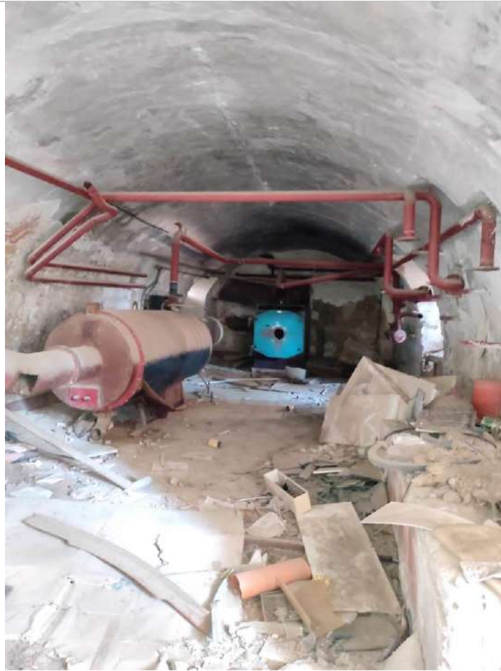
Foto 7: Locali piano seminterrato
