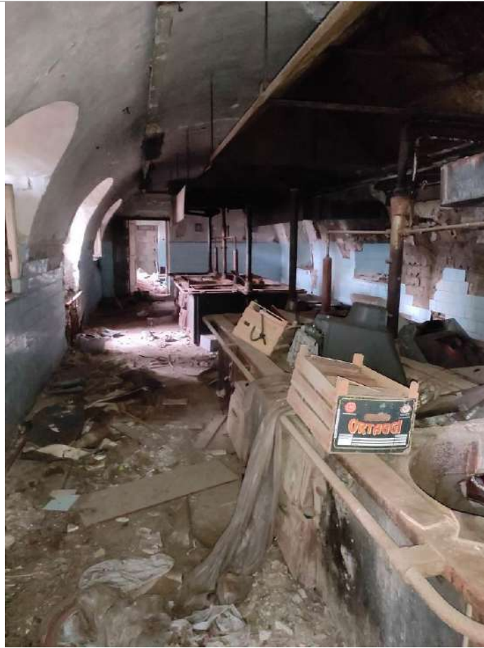
Foto 5: Locali piano seminterrato
