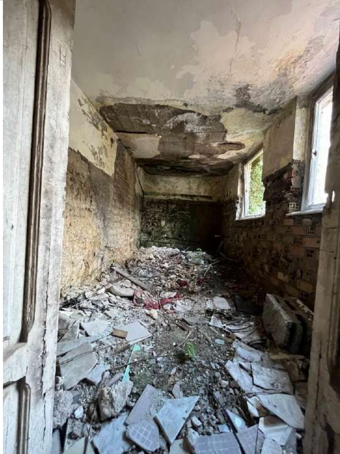
Foto 19: Locali superiori all'accesso al parco
