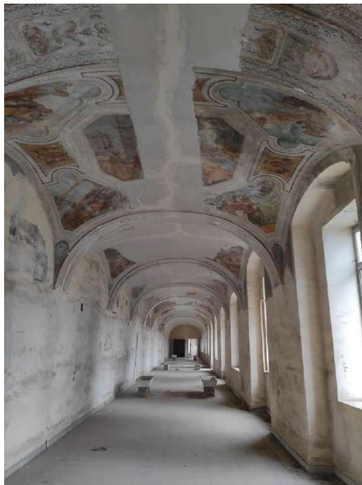
Foto 26: Ambienti Sud Piano Ammezzato Primo
