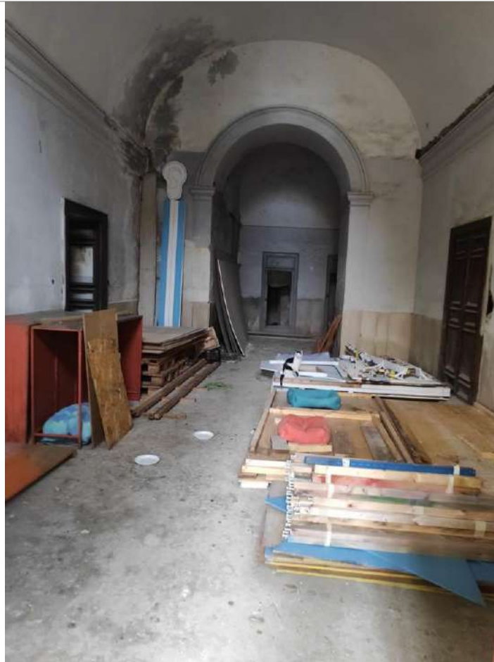
Foto 9: Ingresso lato Sud
