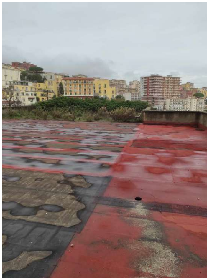
Foto 17: Copertura Locali accesso al parco
