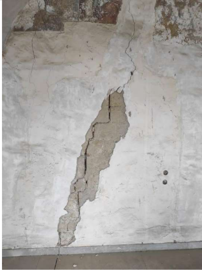
Foto 27: Particolare muartura Piano Ammezzato Primo
