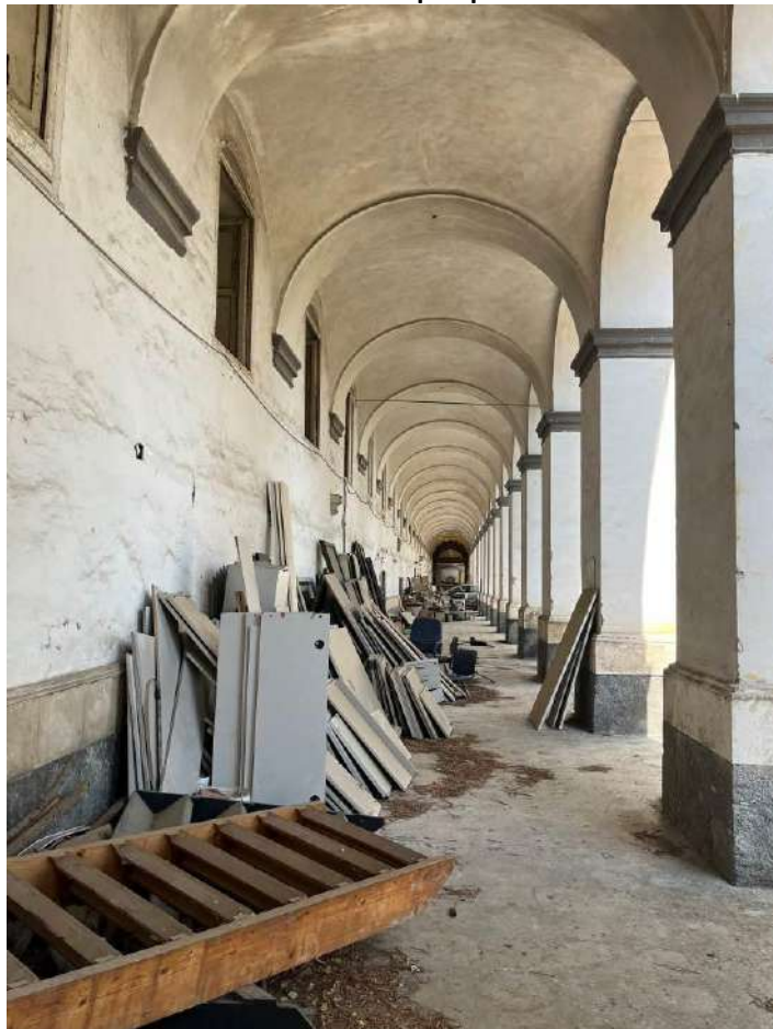
Foto 4: Porticato prospetto Est
