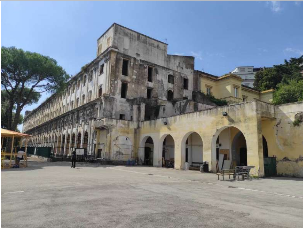
Foto 1: Prospetto Nord - Est
