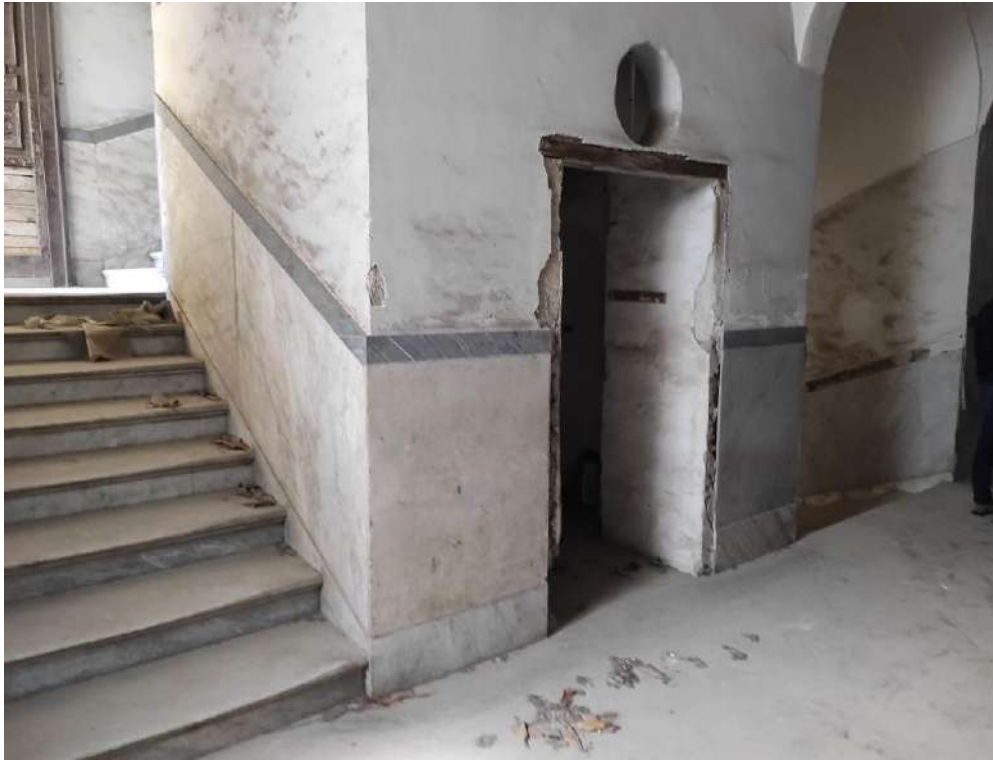
Foto 25: Vano scala Nord
