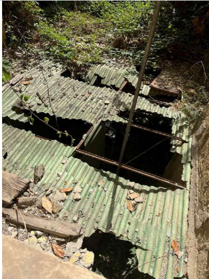
Foto 15: Tettoia cortile Ovest
