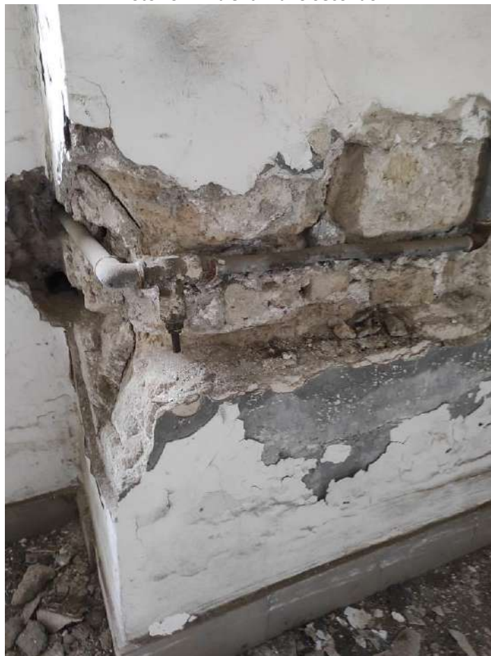
Foto 30: Particolare muratura Piano Secondo
