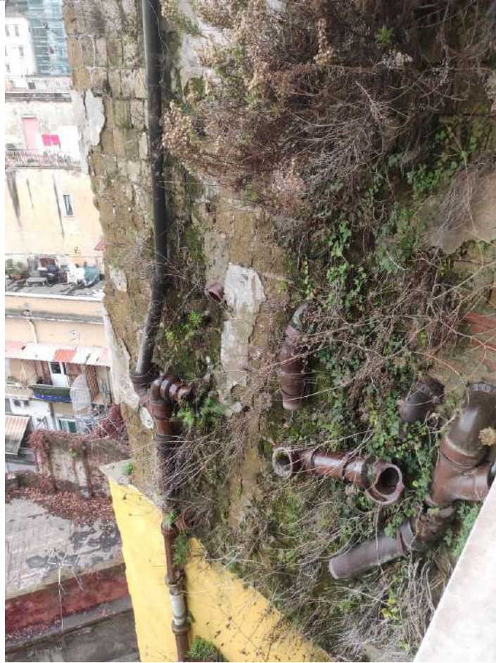
Foto 37: Particolare muratura esterna Piano Secondo
