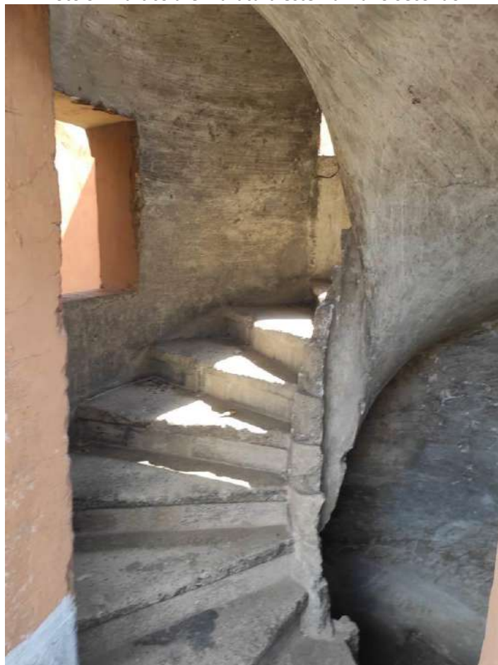
Foto 38: Scala d'accesso alla copertura
