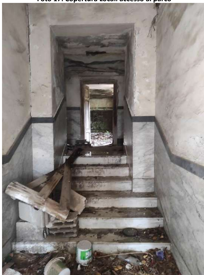
Foto 18: Locali superiori all'accesso al parco
