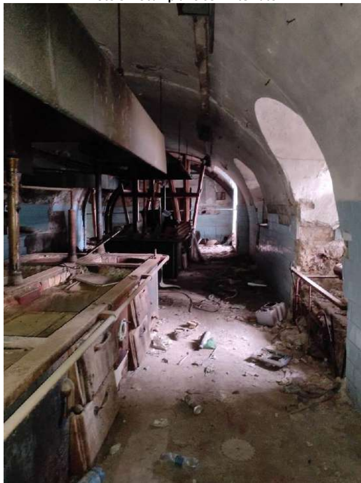
Foto 6: Locali piano seminterrato
