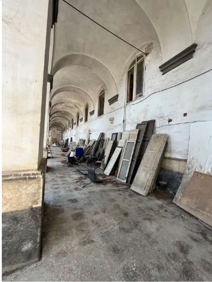
Foto 3: Porticato prospetto Est
