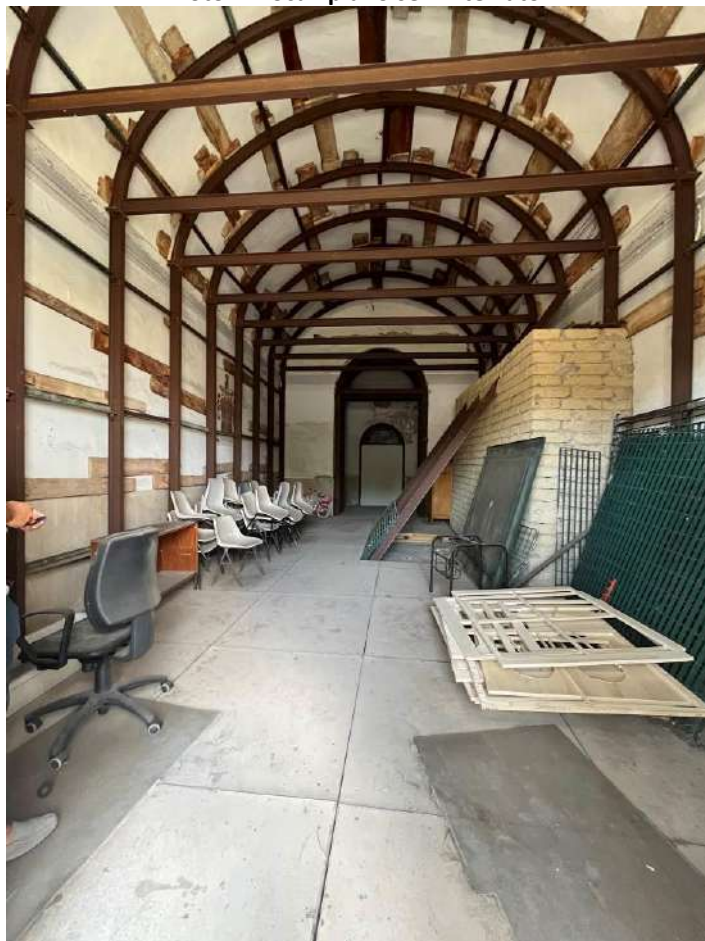
Foto 8: Ingresso lato Nord
