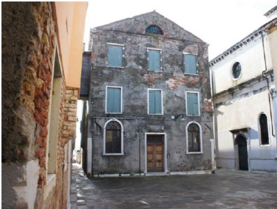
Foto 3 Vista prospetto da Campiello dello Santo Spirito
