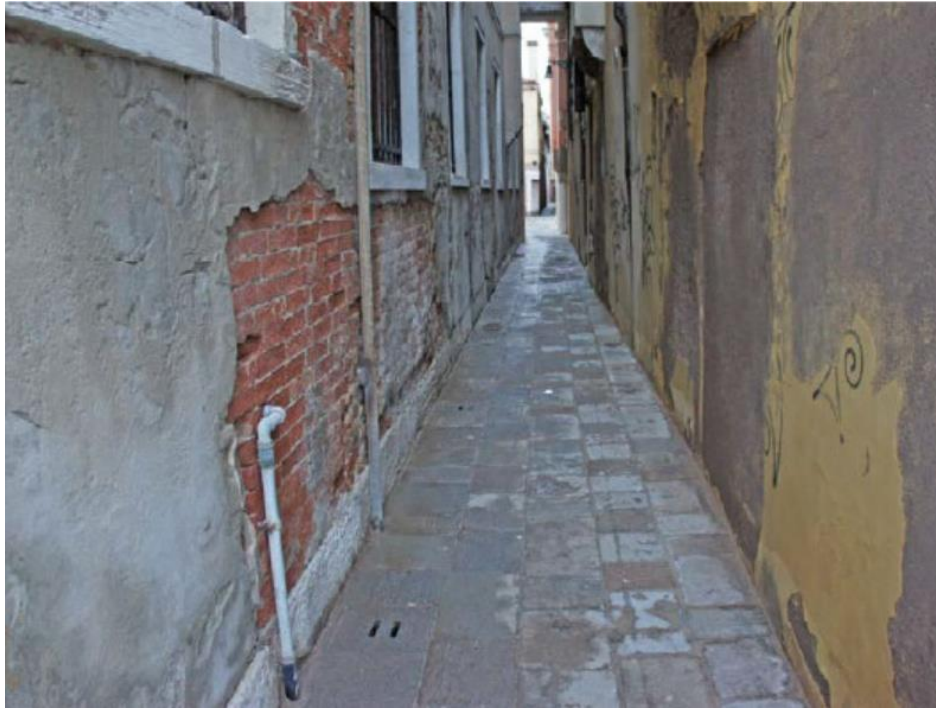
Foto 4 Vista Calle de la Scuola
