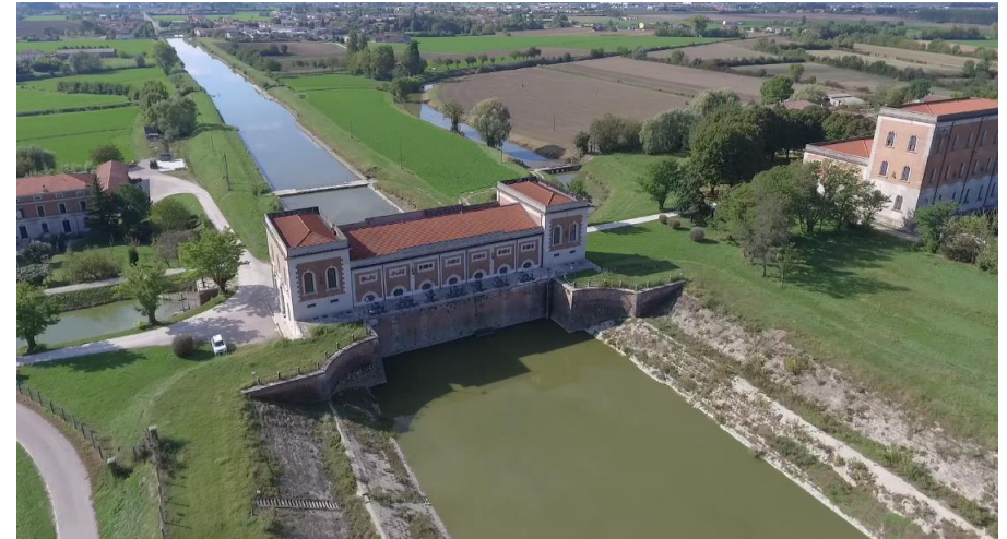
Impianto Idrovoro della travata
